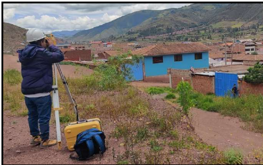
Figura 44. Lectura de buzones con estación total.
