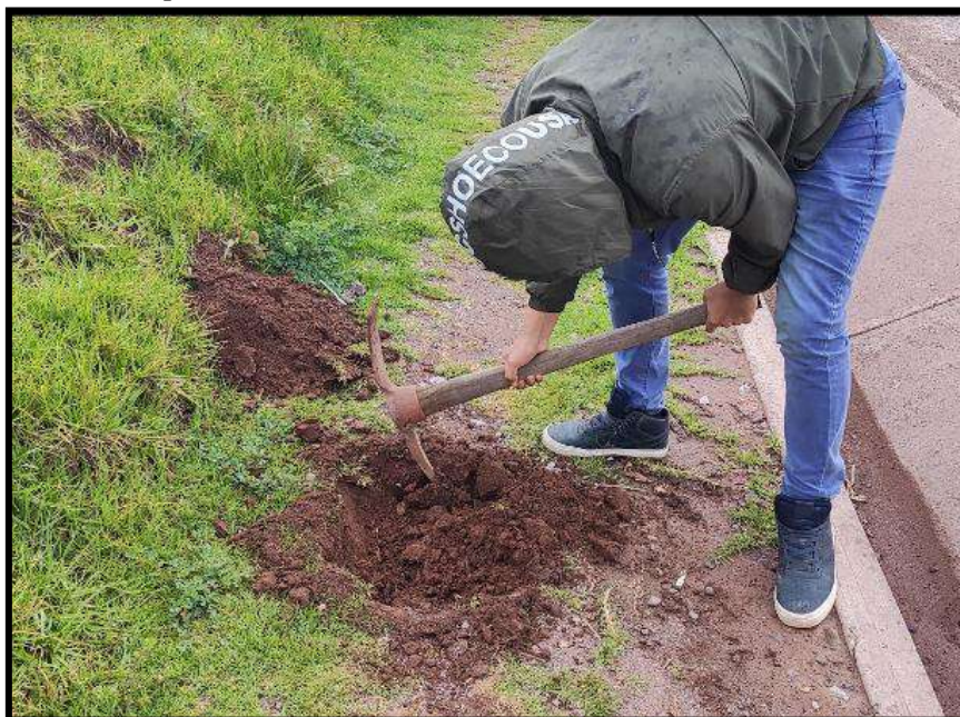
Figura 17. Excavación para realizar la monumentación.
