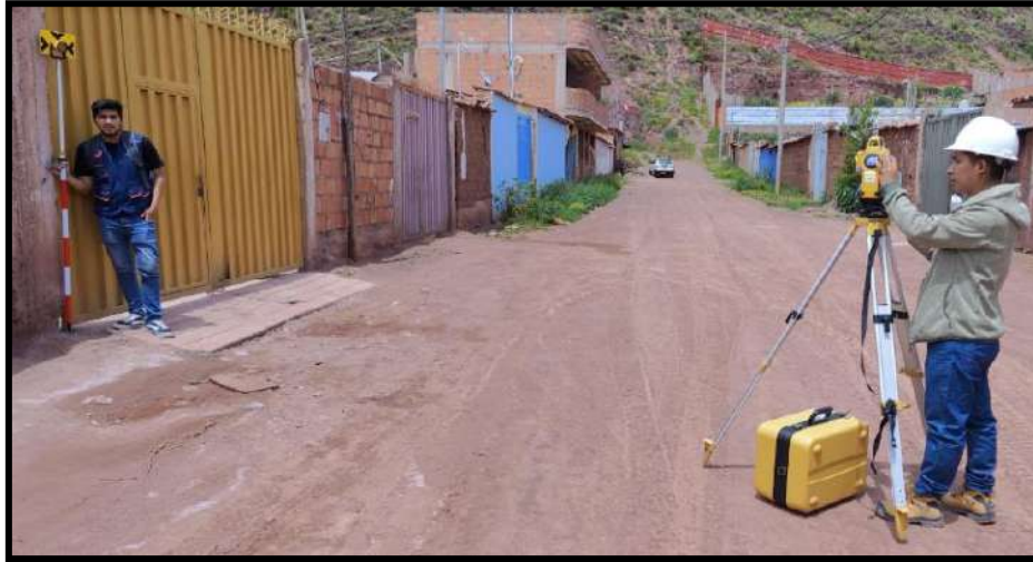
Figura 41. Lectura de límites colindantes de viviendas con estación total.
