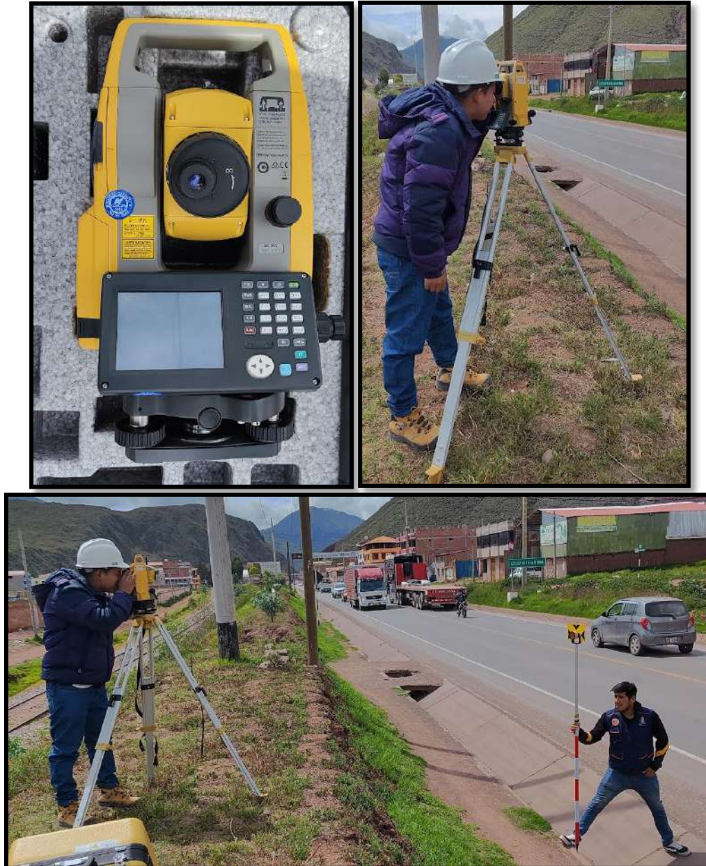
Figura 38. Levantamiento topográfico con estación total.
