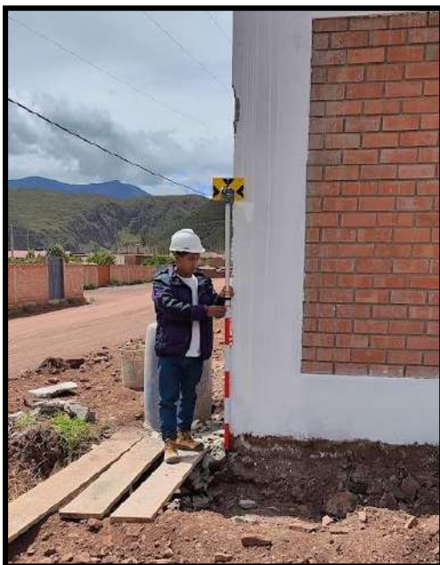
Figura 40. Lectura de los puntos de control o BM con estación total.
