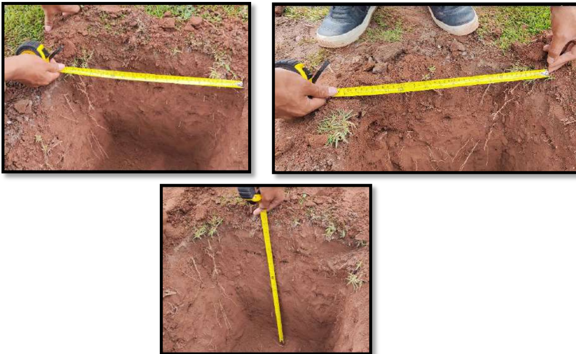
Figura 18. Excavación según dimensiones del IGN.
