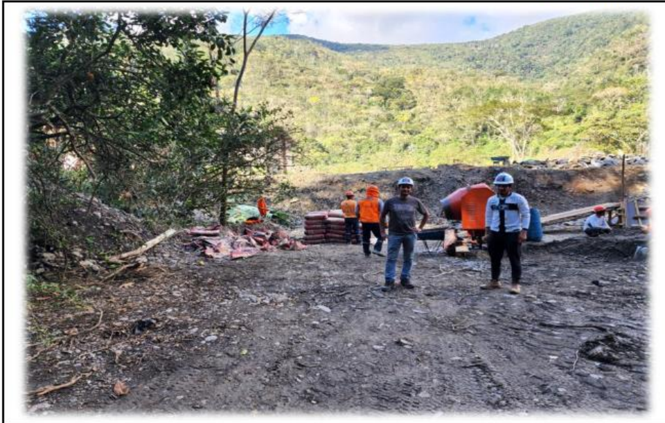
VACIADO DE COLUMNAS CON CONCRETO
