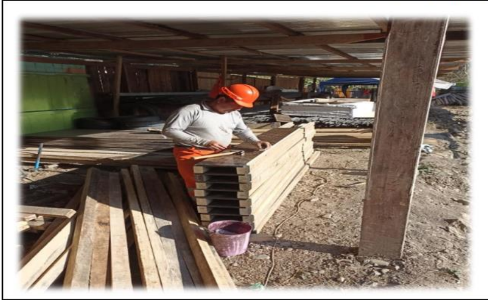
CORTE DE MADERA Y ARAMADO DE FORMAS PARA ENCOFRADO
