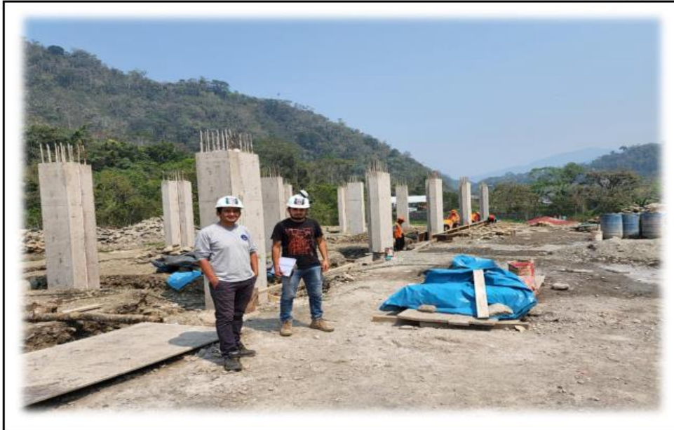
DESENCOFRADO DE COLUMNAS DE CONCRETO
