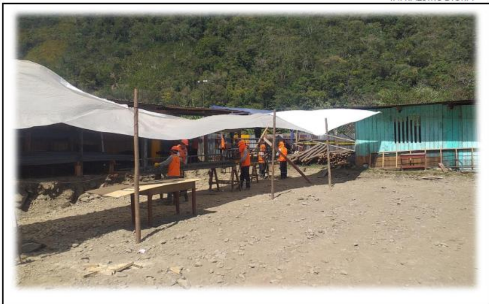
CORTE Y ARMADO DE ACERO
