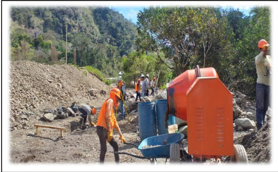
MEZCLA DE CONCRETO PARA ZAPATAS
