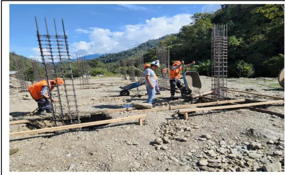
VACIADO DE ZAPATAS CON CONCRETO
