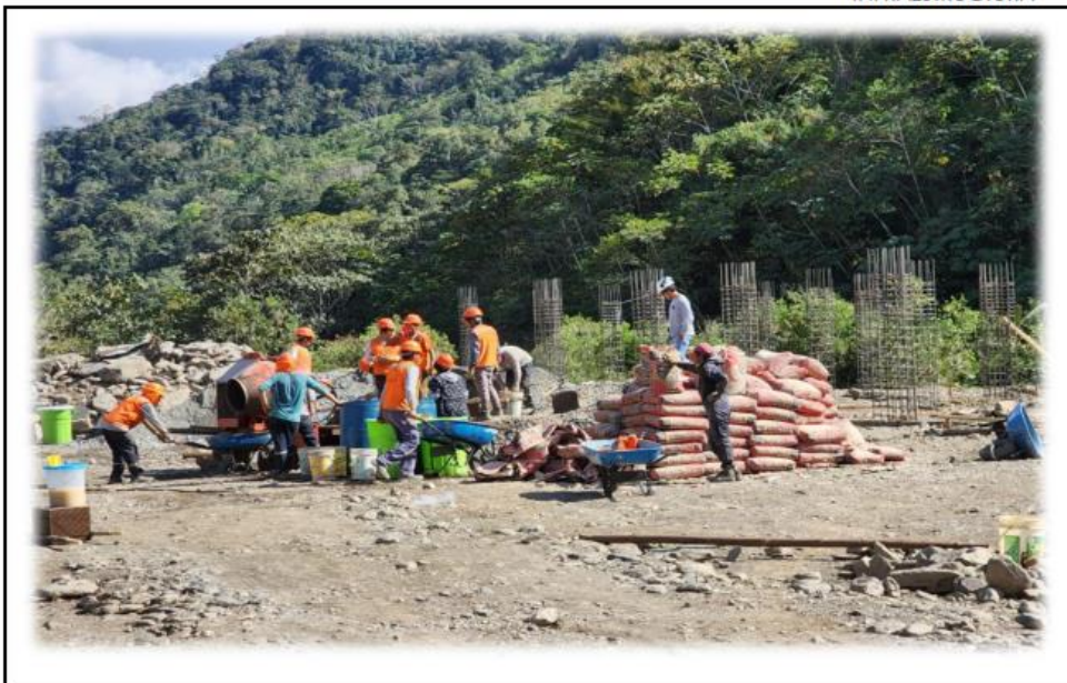
MEZCLA Y PREPARACION DE CONCRETO PARA COLUMNAS
