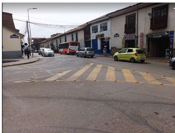
Figura N° 31. Situación Actual de Intersección no semaforizada de Av. Arcopunku- Plazoleta Rimaqpampa
