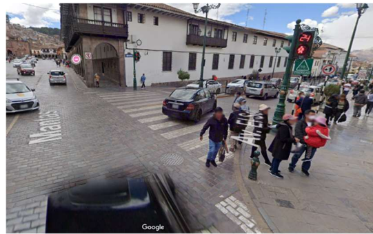
Figura N° 06. Intersección semaforizada de Av. Sol- Calle Mantas
