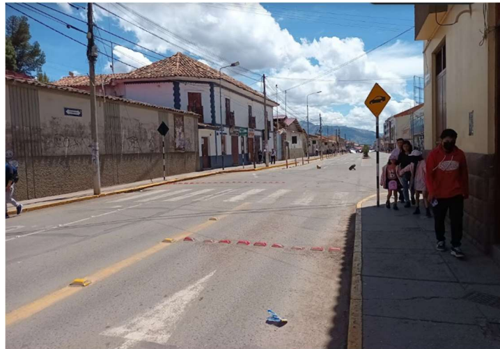
Figura N° 33. Situación Actual de Intersección no semaforizada de Av. Arcopunku-Av. Huáscar
