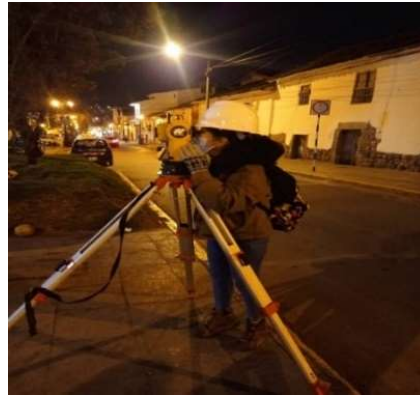
Figura N° 91. Uso de la estación total, trípode y prisma en la Av. Tullumayo.
