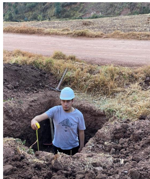
Fotografía 04: Excavación de Calicatas
