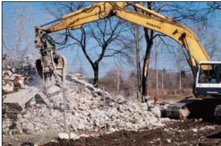
FIGURA 16 DEMOLICIÓN DE ESTRUCTURAS
