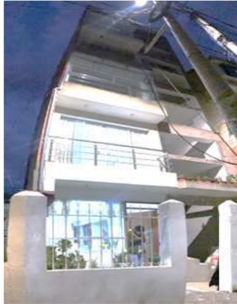
Figura 4 Vista lateral de Edificación N°5.
