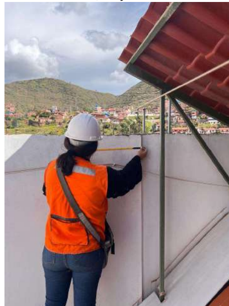
Figura 43 Identificación de Irregularidades en Altura, Edificación 1.
