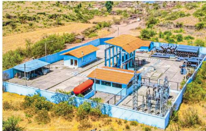
Figura N° 12 Estación de Bombeo de Rumicolca
