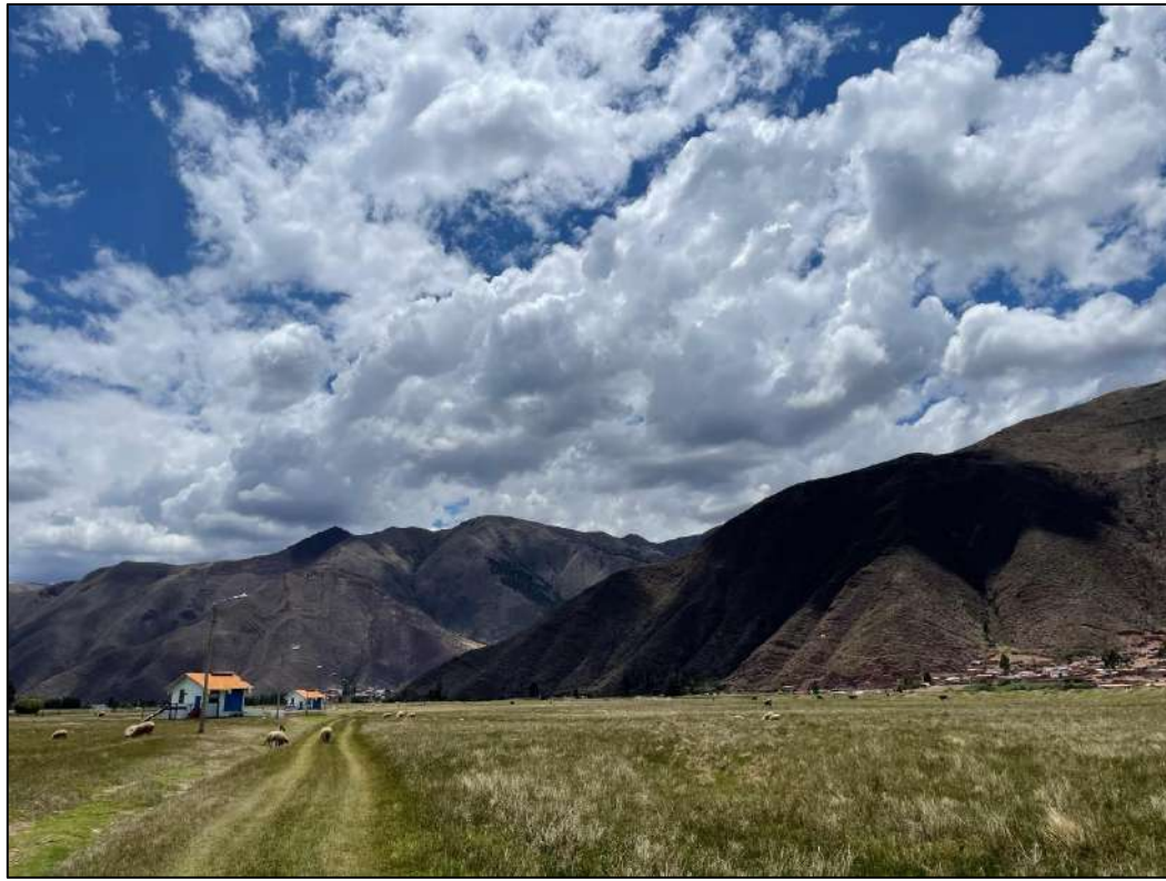
Foto N° 01: Estación de bombeo 01: Piñipampa vista general
