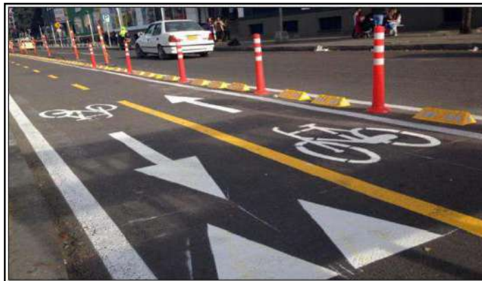
Figura 36: Ejemplo de demarcación horizontal en ciclovía
