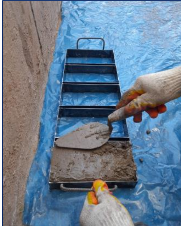
Figura 48: Colocación de la mezcla en las adoquineras
