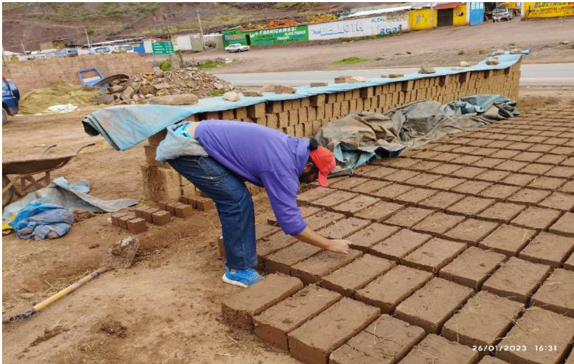
Figura 74: Colocado de nomenclatura a los adobes para distinguirlos.
