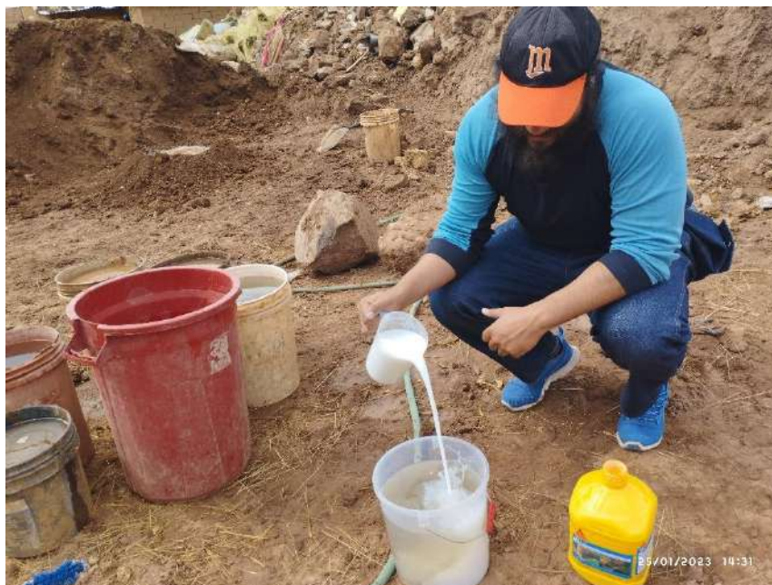
Figura 63: Mezclado de aditivo impermeabilizante Sika-1 con el agua
