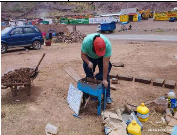
Chusado de tierra para luego ser compactada y evitar espacios vacíos
