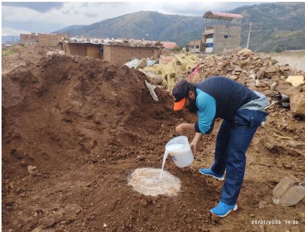
Figura 64: Preparado de suelo con Aditivo Sika-1.
