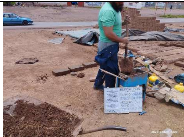
Llenado de maquina compresora de adobes con tierra mezclada con aditivos.
