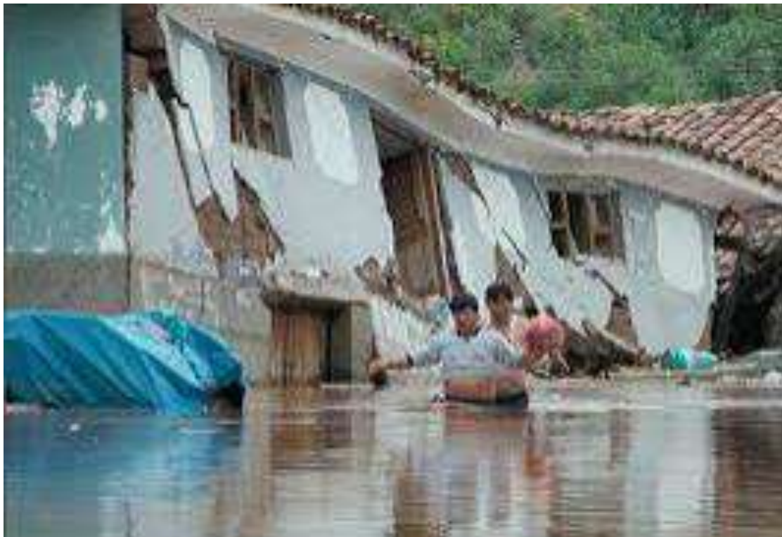
Figura 2: Inundación que afecta a construcciones de adobe.
