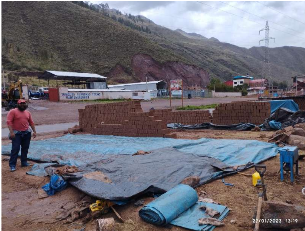
Figura 76: Cubertura de adobes contra friajes y posibles lluvias
