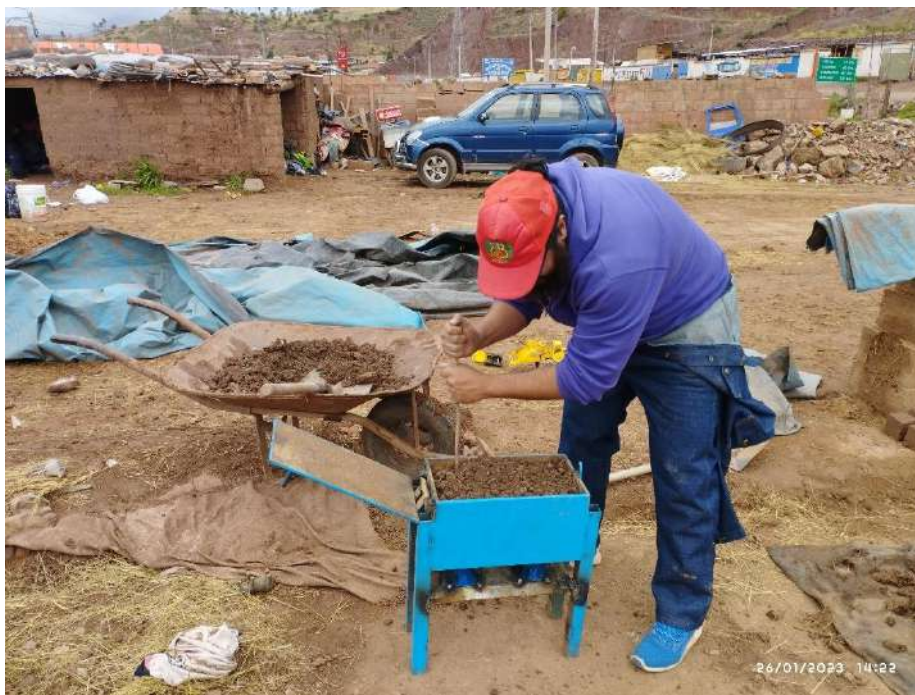
Figura 69: Chuseamos el material en 3 capas para un mejor compactado.
