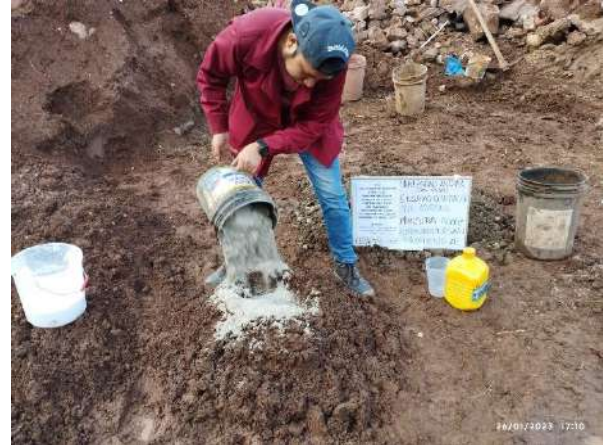
Mezclado de cemento con suelo
