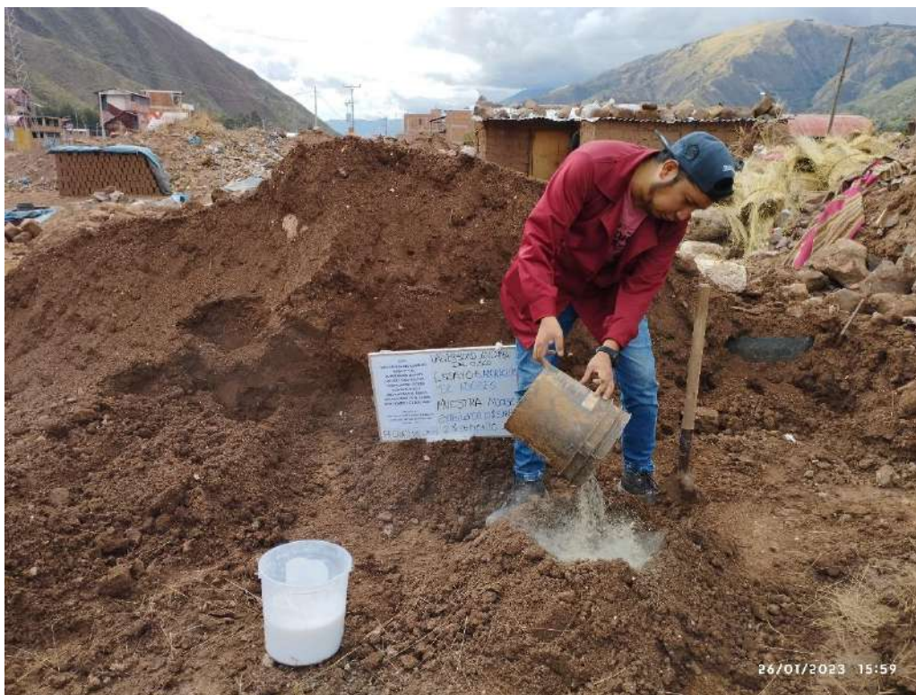
Figura 65: Mezclado de suelo con cemento.
