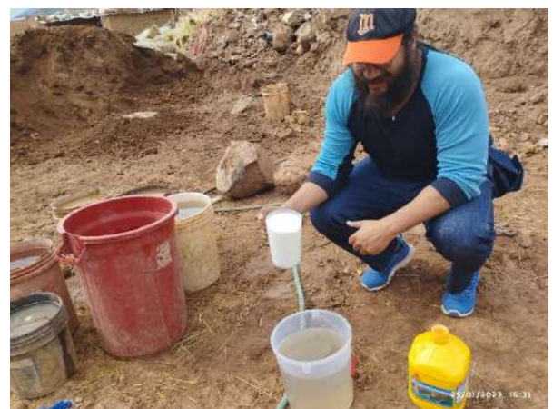
Mezclado de aditivo Sika-1 con agua
