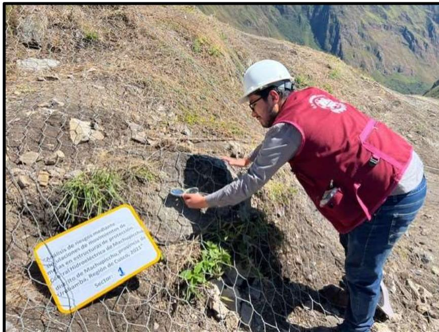
Fotografía de la masa superficial por deslizarse, sujetas con una malla metálica.
