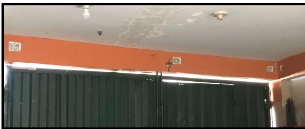
Figura 43: Trabajo de picado en elementos estructurales – Superestructura sin asistencia técnica.
