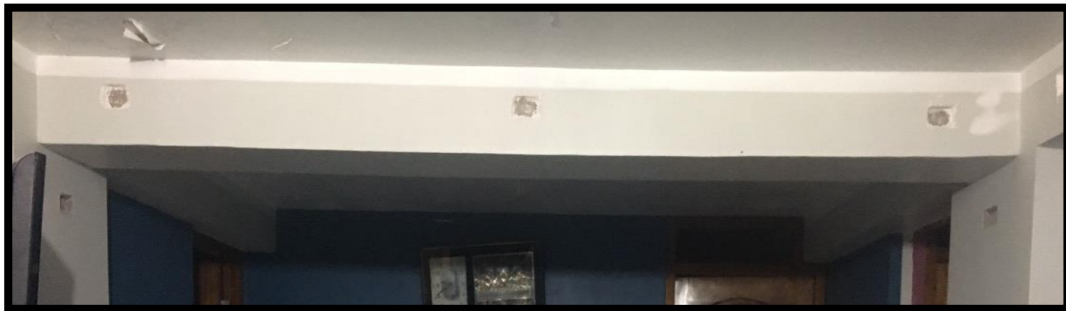
Figura 37: Vista frontal de elementos estructurales tipo columna, viga con picado para ensayo de esclerometria.
