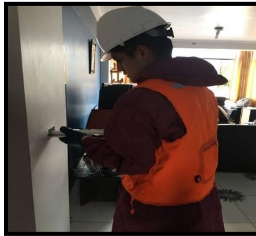
Figura 39: Toma de lectura para ensayos de esclerometría en vigas
