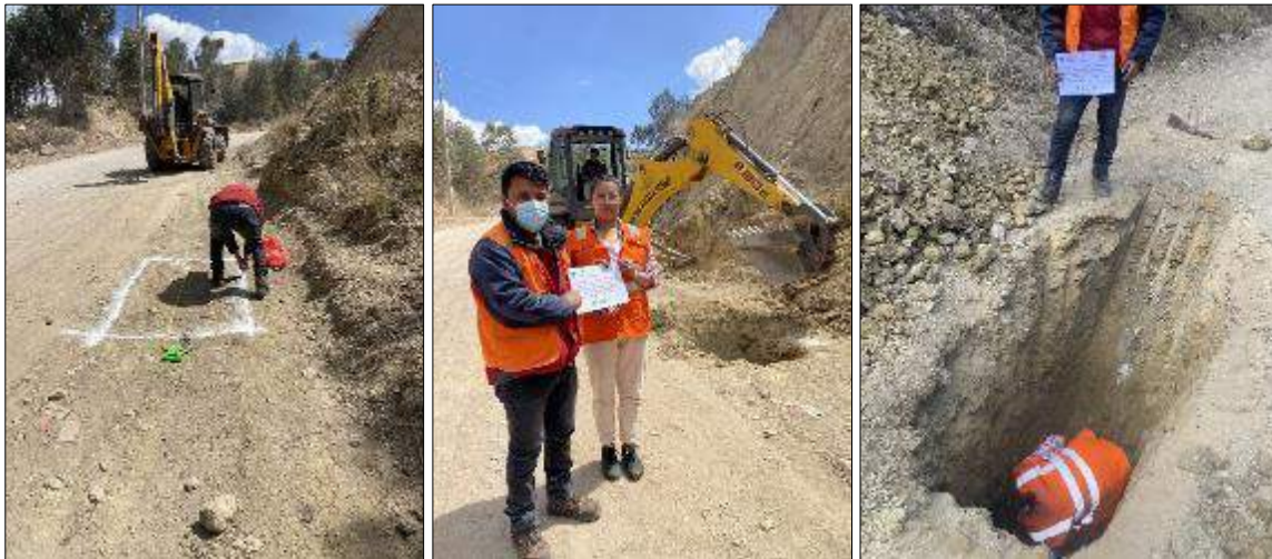
Ilustración 12: Trazado, excavación de calicata y extracción de muestra
