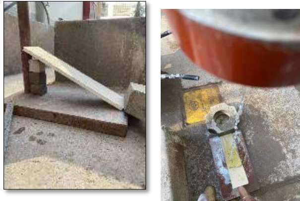
Ilustración 52: Instalación del equipo de SAET y colocación de bloques
