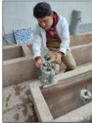
Ilustración 46: Colocación de trípode
