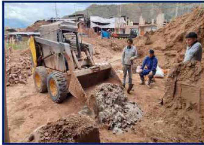
Figura 24. Proceso de mezclado de arena, arcilla, vidrio triturado.
