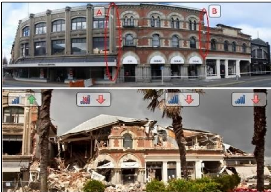
Figura 01: Colapso en Christchurch, Nueva Zelanda, 2010
