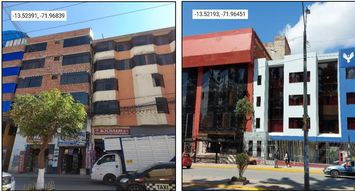
Figura 03: Colección de imágenes de edificaciones sin adecuadas juntas sísmicas en la Ciudad de Cusco
