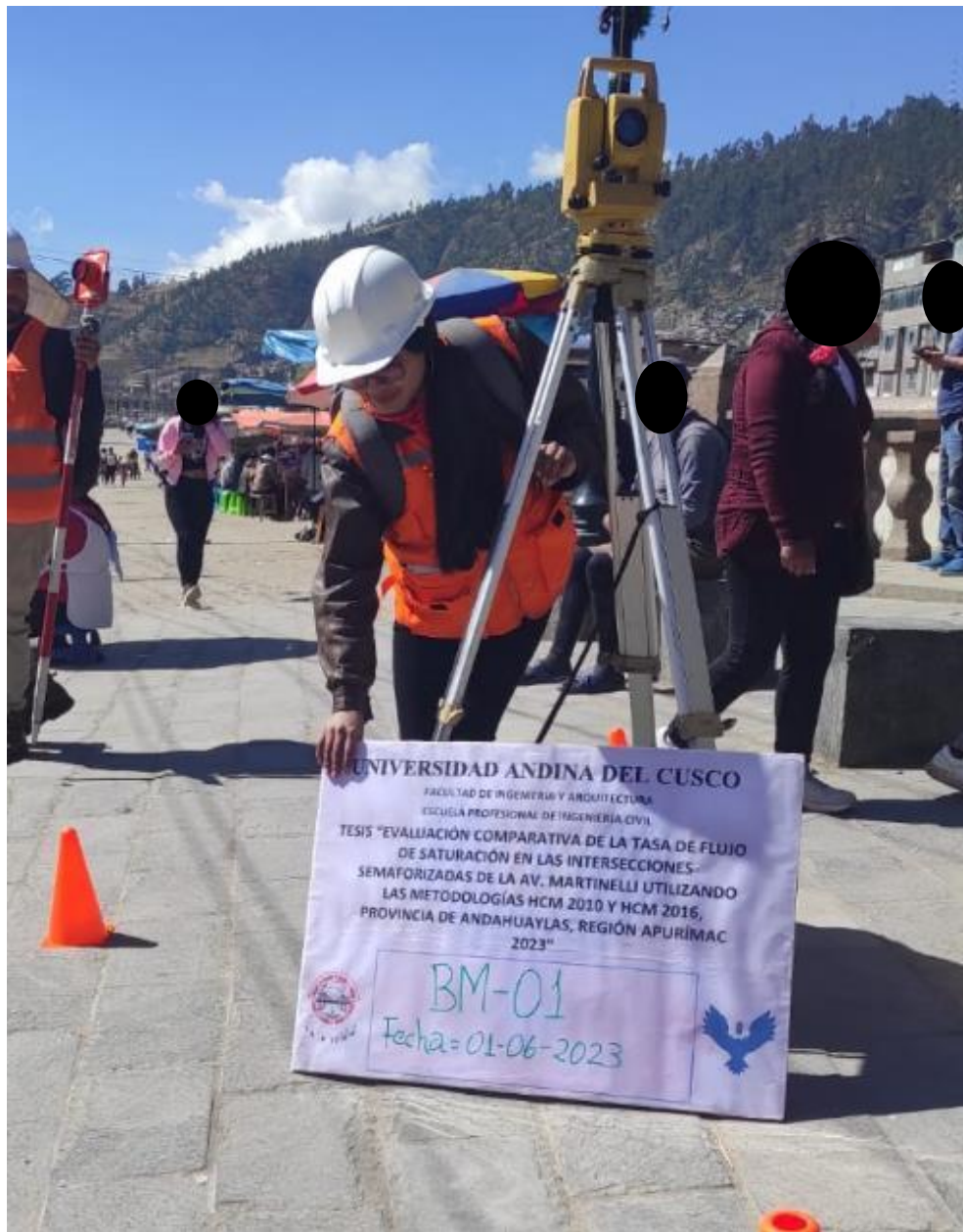
Figura 15: BM 01, primer punto de estacionamiento del equipo topografico
