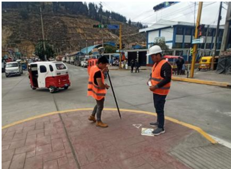
Figura 14: Toma de punto para el BM 02.
