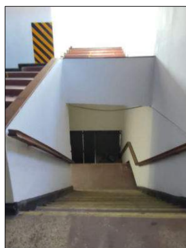
Puerta de ingreso secundario y escaleras ala mezanine
