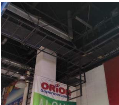
Parte de la estructura de la tramoya del escenario
