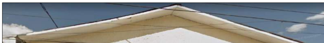
Estructura de Cubierta a dos aguas
