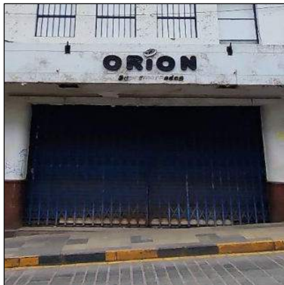
Ingreso principal y marquesina
