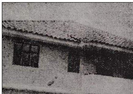
Ventanas del segundo nivel y configuración del techo
