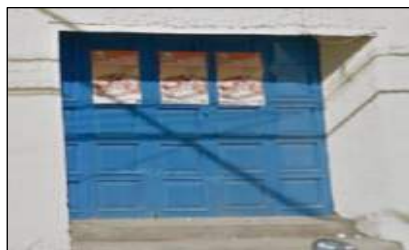
Antigua Puerta de Ingreso
