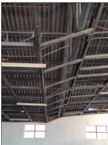
Estructura del techo
