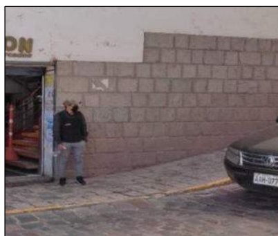
Revestimiento exterior nuevo de la fachada exterior
