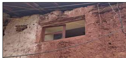
Ventanas interna y muro de abobe en el segundo nivel
