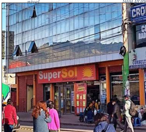
Actual estado de la fachada del cine con la implementación de nuevos pisos superiores.
