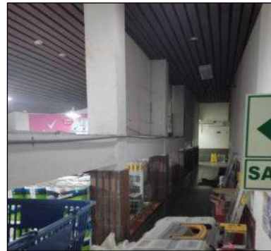
Actual ingreso de la platea debajo del mezanine
