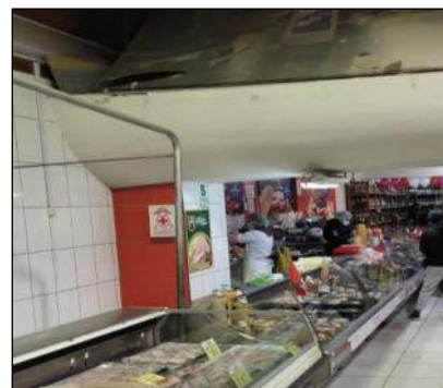
Estructura de soporte del mezanine
