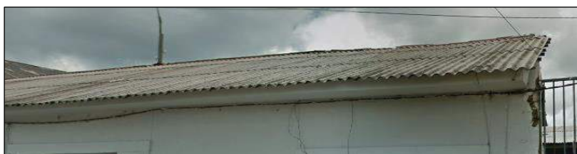
Cubierta de dos aguas de calamina
