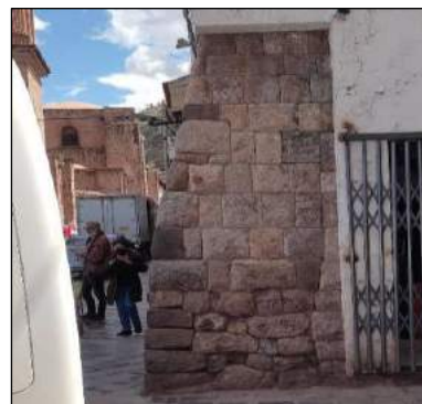
Vista actual del muro inca en la base de la fachada frontal
