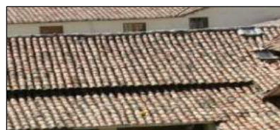
Techo a dos aguas
