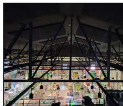
Estructura interna de los techos
