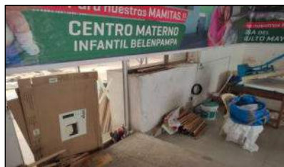
Vista interna de los muros
