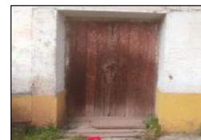
Salida de emergencia lateral
