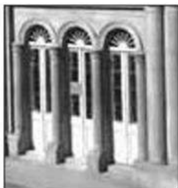
Ventanas con un arco de medio punto y marcos de madera
