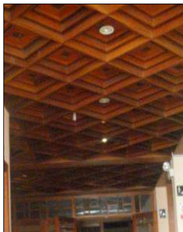
Configuración del techo actual del foyer
