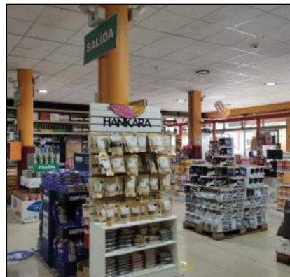
Columnas del primer nivel
