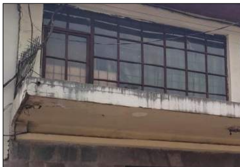
Marquesina de concreto y ventanas del segundo nivel
