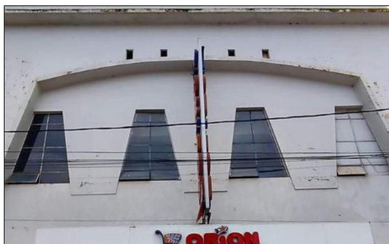
Configuración de las ventanas en la fachada principal
