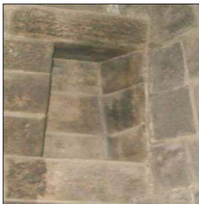
Ventana en el muro inca
