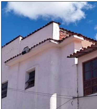
Ventanas del tercer nivel y techos
