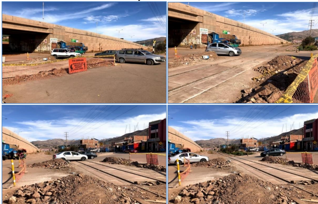
Fig. 13: Vía Evitamiento (altura Maestro – Servicentro Santa Elena).
