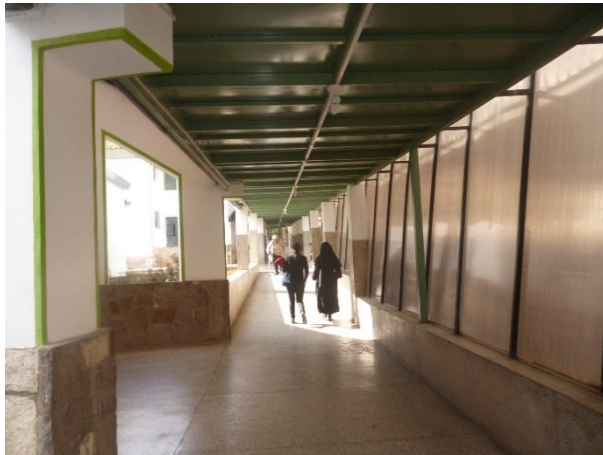
Figura 6 "Pasadizo del Centro Gerontológico San Francisco de Asís": Fuente propia
