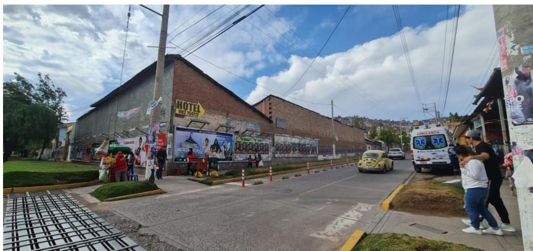
Figura 26 Inicio de calle Manzanales
