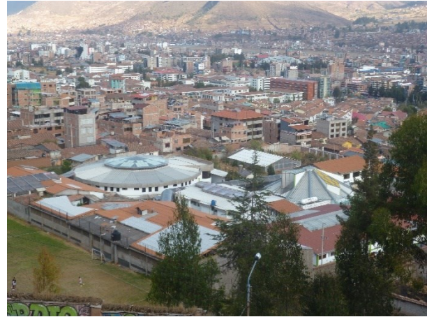
Figura 5 "Vista Superior del Centro Gerontológico San Francisco de Asís": Fuente propia
