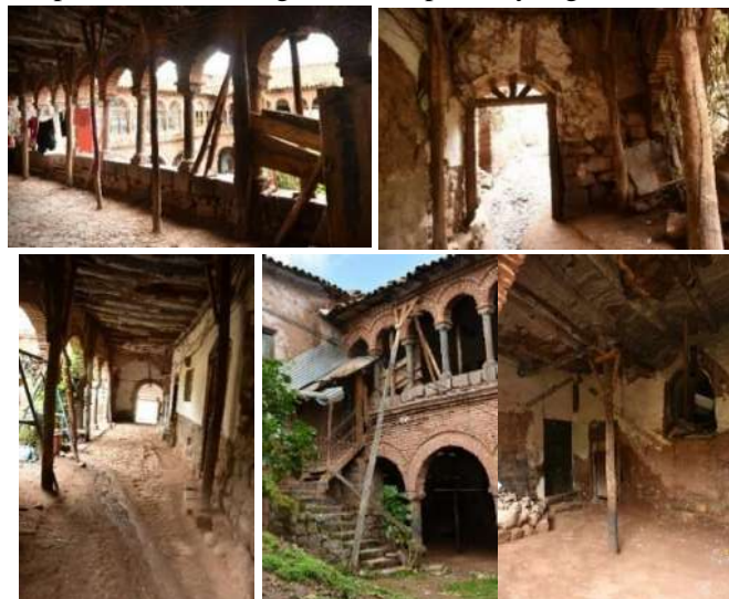
Apuntalamiento en galerías del primer y segundo nivel.
