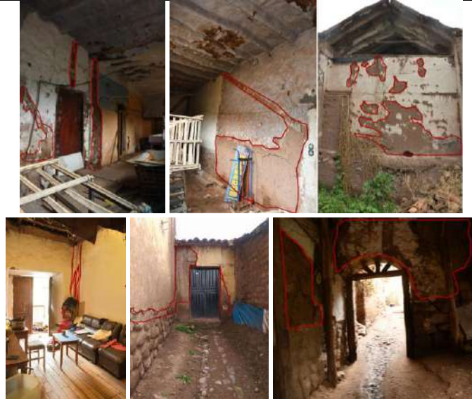
Desprendimiento de material constructivo (ladrillo).
