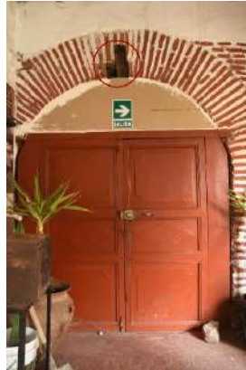
Desprendimiento de material constructivo (ladrillo).
