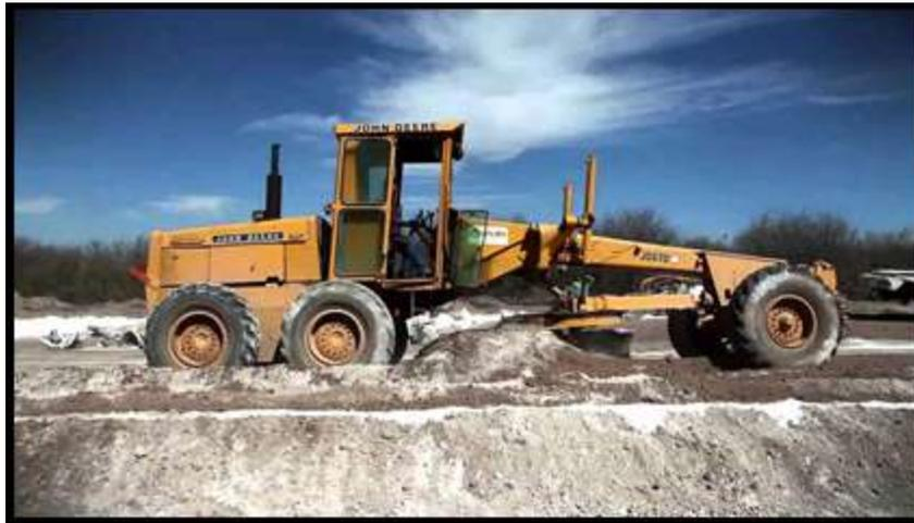
*Nota:* Adaptado de Estabilización de suelos con cal[imagen], por V. Yepes ,2021, Universidad Politécnica de Valencia, (<https://victoryepes.blogs.upv.es/tag/cal/>).
