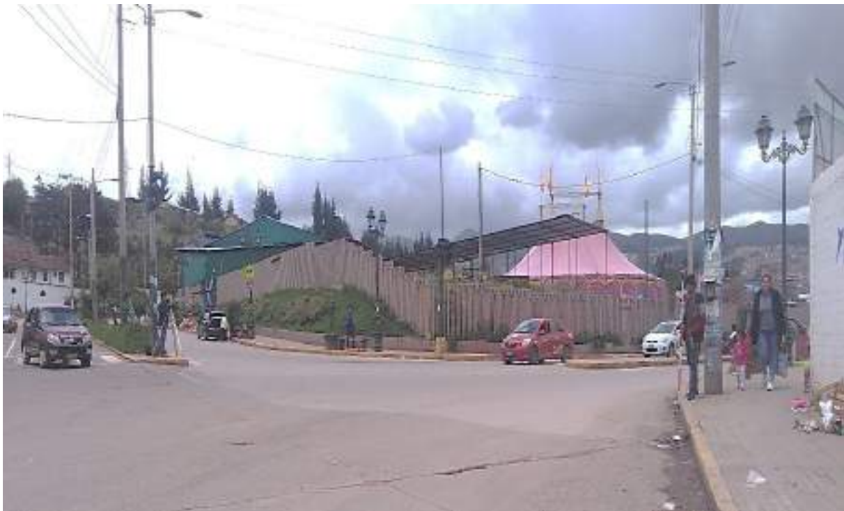
figura 87 levantamiento topográfico en la intersección semaforizada: Avenida Agustín Gamarra – Prolongación Avenida Grau
