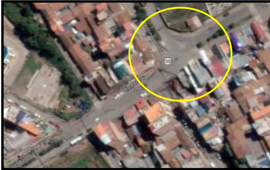
figura 14: Intersección Prolongación Avenida Grau – Avenida Antonio Lorena
