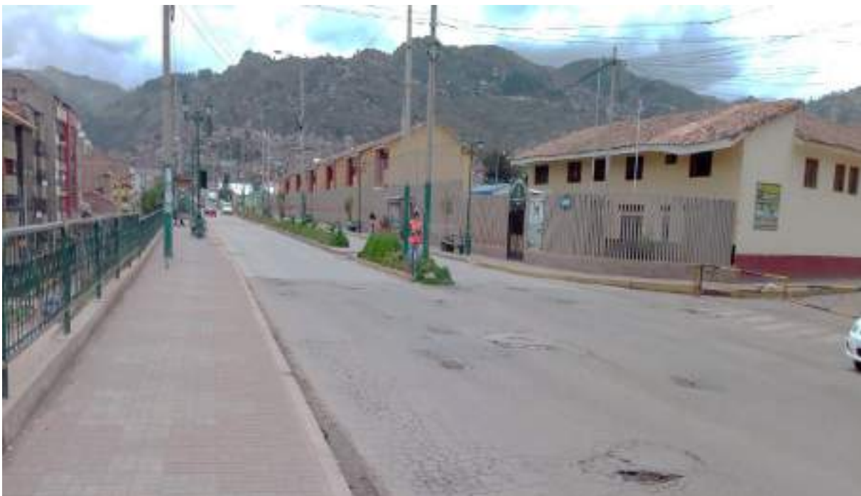
figura 83 Levantamiento topográfico en la intersección no semaforizada: Avenida Agustín Gamarra – Avenida Alfonso Ugarte
