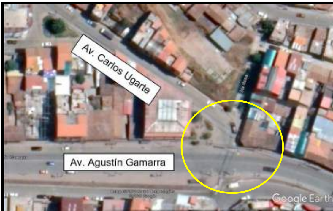
figura 9: Intersección Avenida Agustín Gamarra – Avenida Carlos Ugarte
