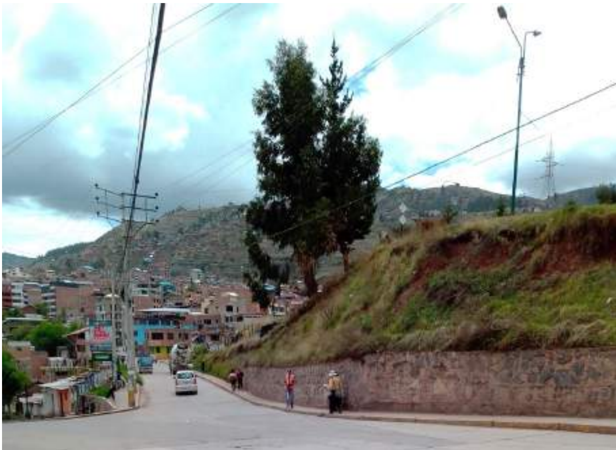
figura 92 levantamiento topográfico en la intersección no semaforizada: Prolongación Avenida Grau – Avenida Perú
