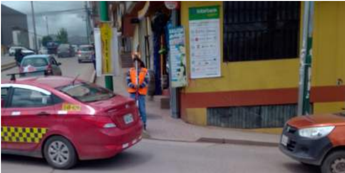
figura 104 levantamiento topográfico en la intersección no semaforizada: Avenida Alfonso Ugarte – Avenida Carlos Ugarte
