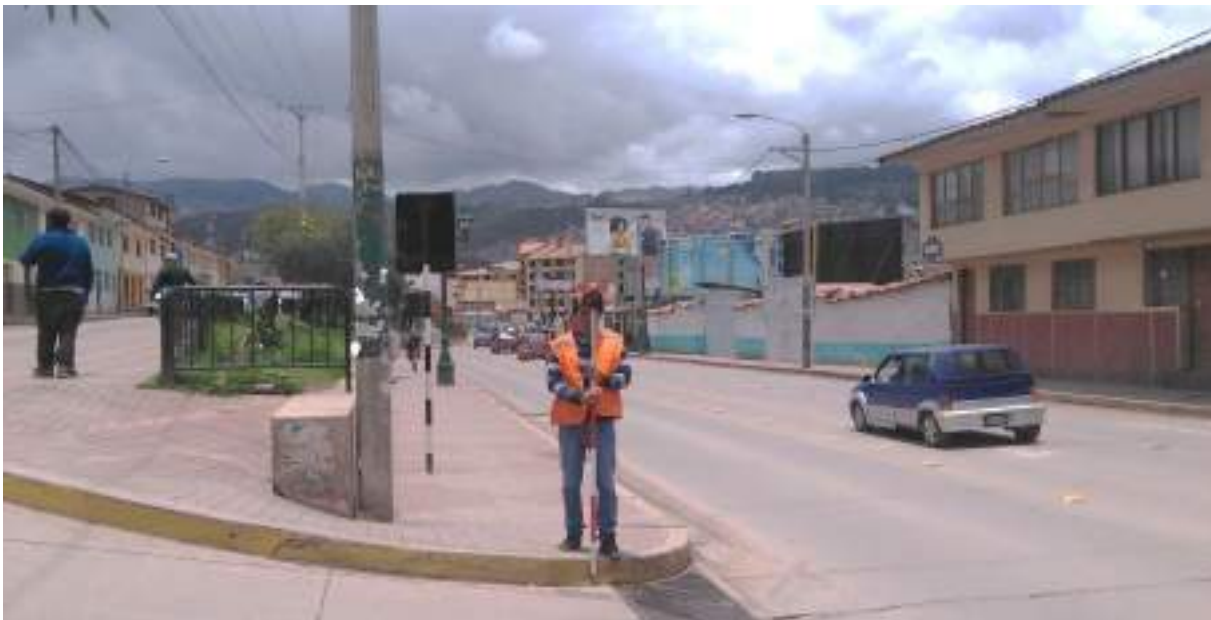
figura 65 levantamiento topográfico en la intersección semaforizada: Avenida Agustín Gamarra – Calle Hipólito Unanue
