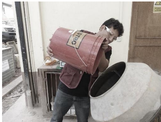
Figura 5 Agua de mezcla – bebible & potable.
