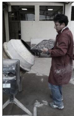
Figura 43 Preparación del concreto.
