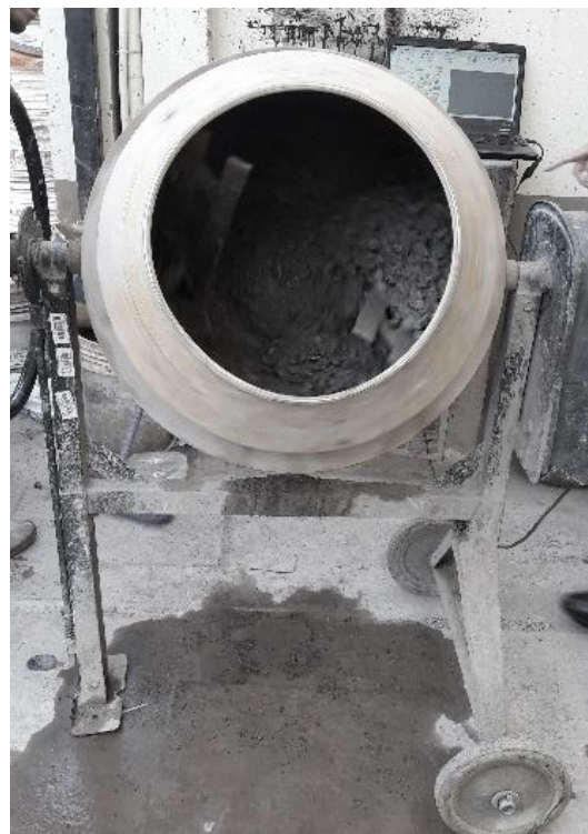
Figura 3 Mezcla de concreto.
