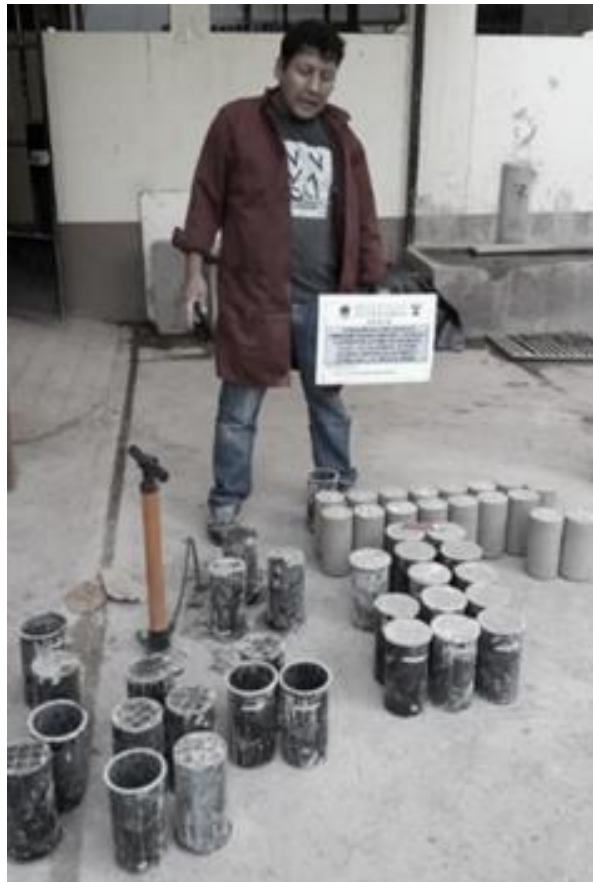
Figura 48 Desmolde de probetas-testigos de concreto.
