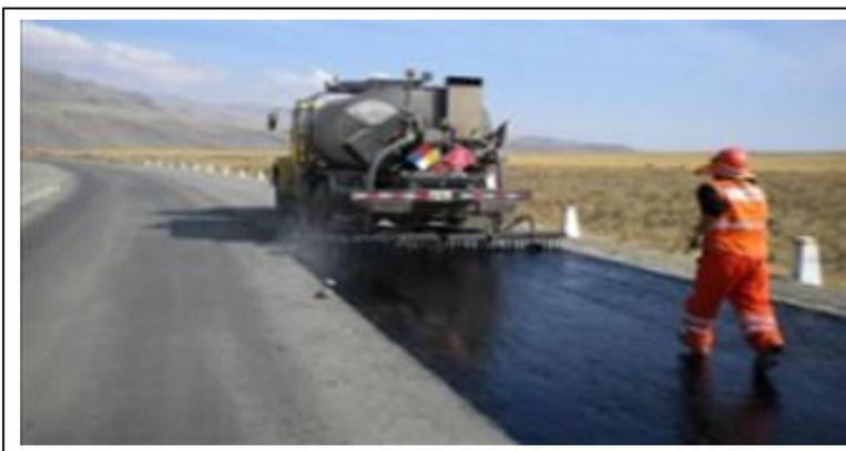
*Fuente:* Imprimación Asfáltica, Km 2+400 carretera Conocacha – Antamina.
