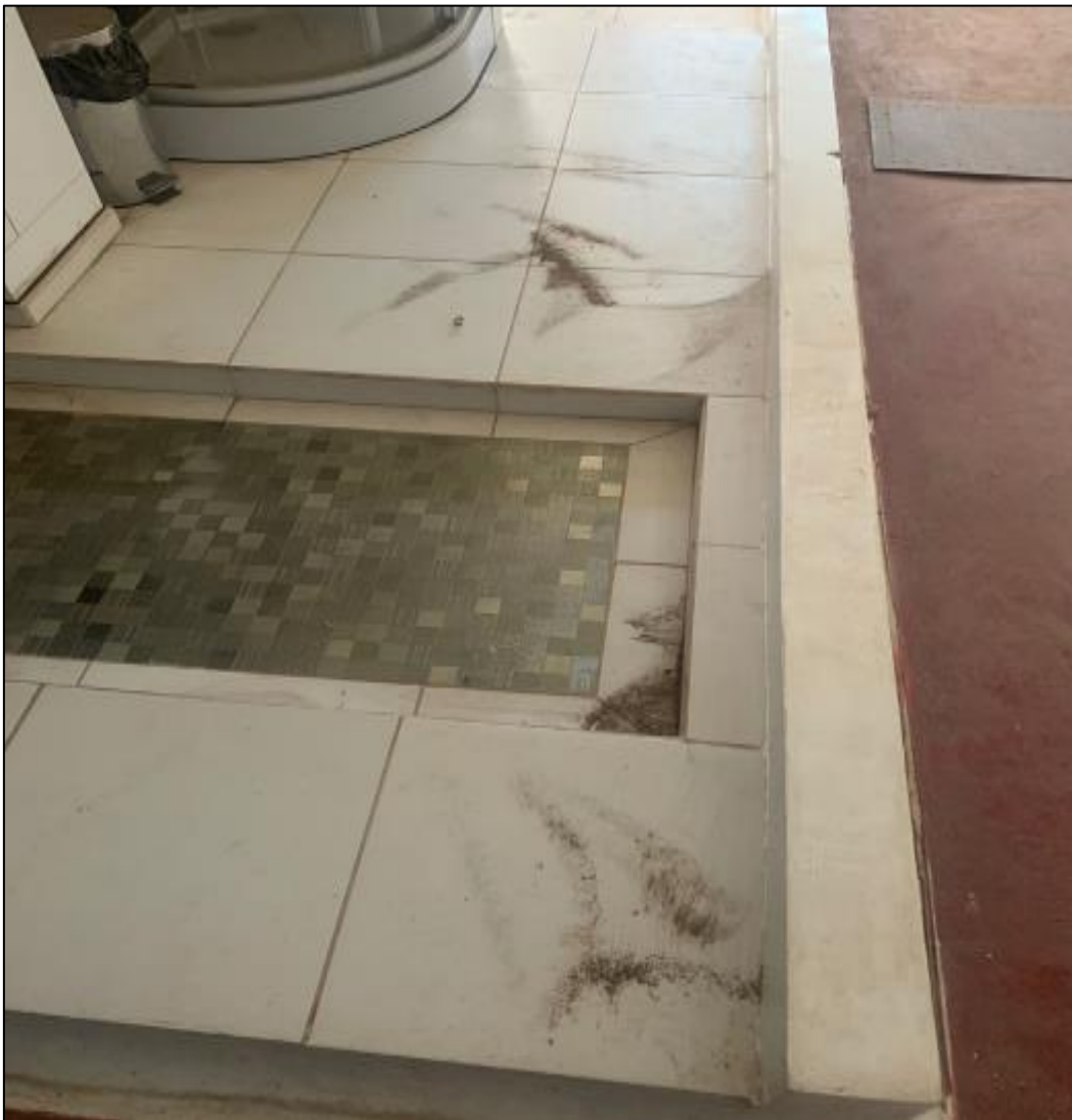
Figura 45: Zona Desinfección De Zapatos Y Cámara De Aire.
