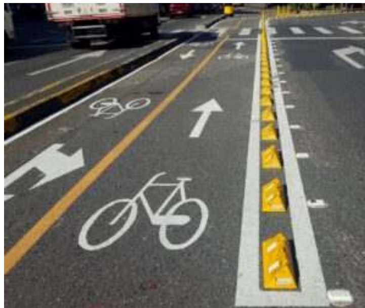
Figura N° 40: Líneas de demarcación horizontal
