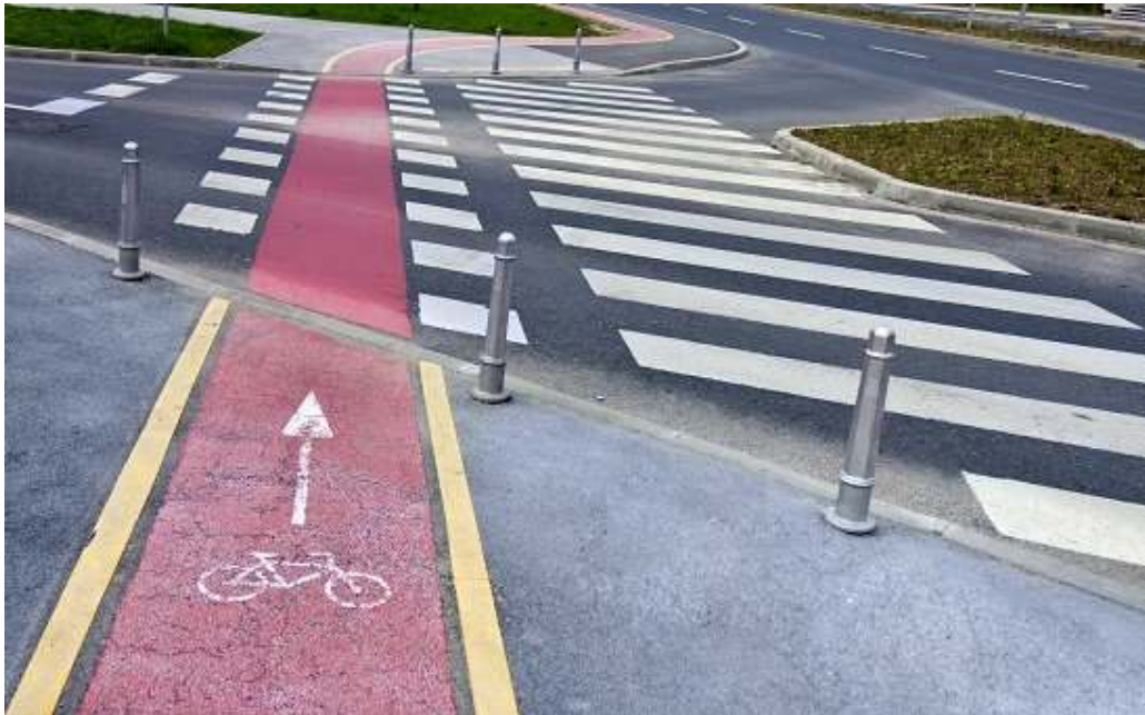
Figura N° 42: Líneas de canalización en paso para ciclistas en el caso de vía ciclista sobre la calzada (izquierda) y sobre el andén (derecha)
