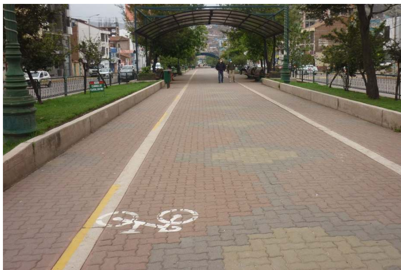
Figura N° 136: Av. Alameda Pachacutecq carril de subida Elaboración Propia
