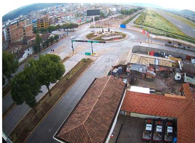
Figura N° 93: Centro de Monitoreo y seguridad ciudadana de la Municipalidad de Santiago Fuente Propia
