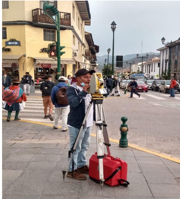
Figura 105: Recolección de datos con estación total Av. el sol con Ayacucho
