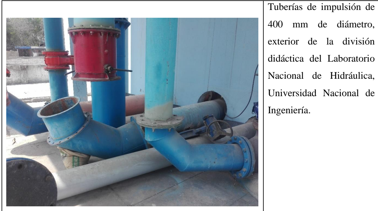
Figura 29: Condiciones iniciales de la línea de conducción
