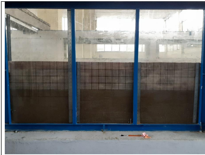
Figura 35: Colocado de Plexiclass cuadrado
