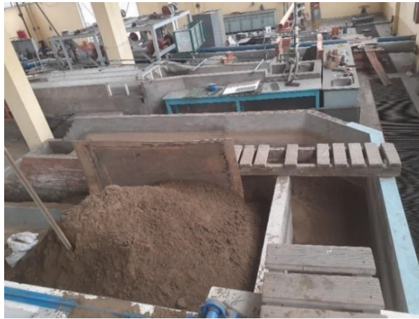
Fotografía 8: Desarenador e ingreso a la cisterna
