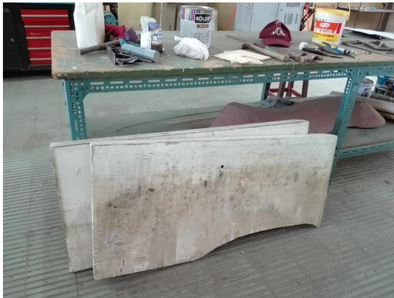
Figura 32: Mantenimiento de muros divisores del barraje
