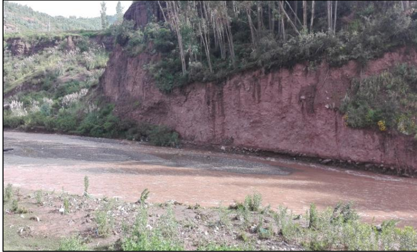
Fotografía 1: Erosión Transversal del Rio Huatanay, Cusco
