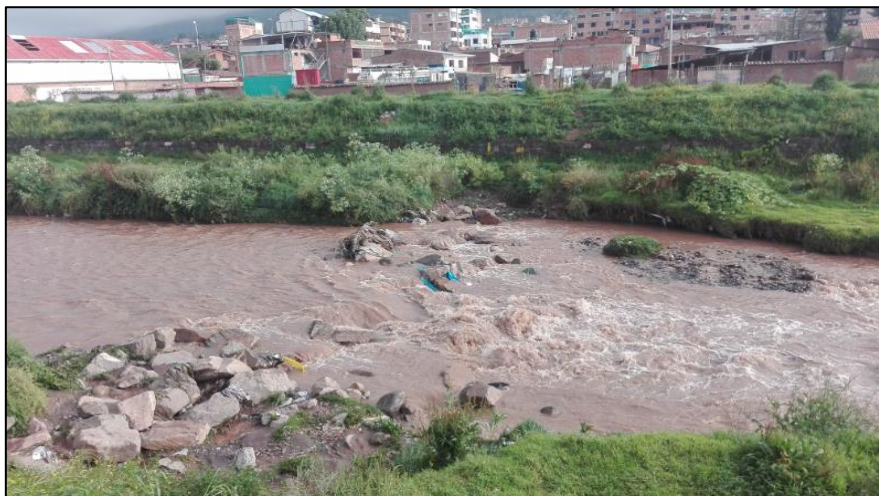
Fotografía 2: Erosión total Río Huatanay, Cusco
