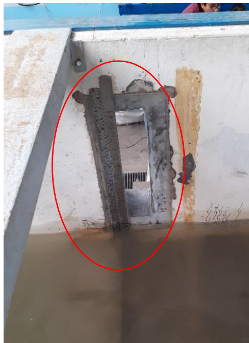
Fotografía 10: Regla metálica para medición de tirante aguas abajo
