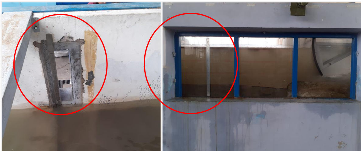
Fotografía 26: Regla metálica para medir tirante aguas arriba y abajo.
