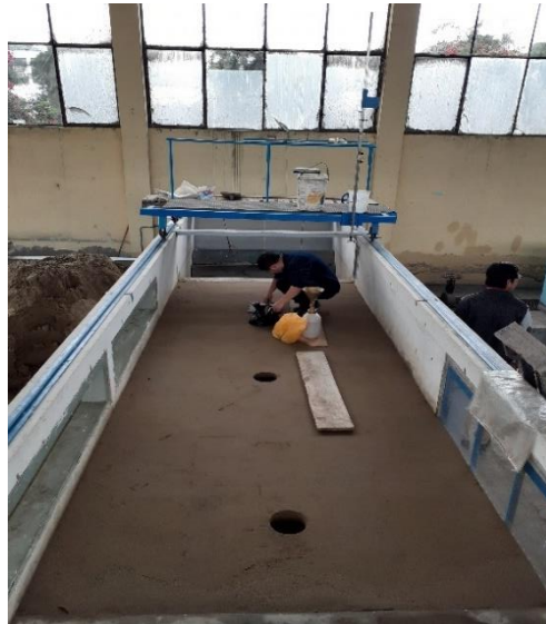
Fotografía 20: Extracción de muestra para el ensayo cono de arena
