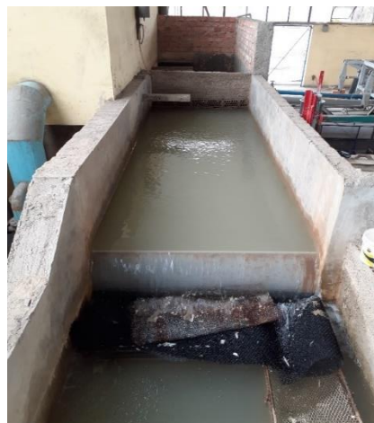
Fotografía 5: Zona de disipación de energía
