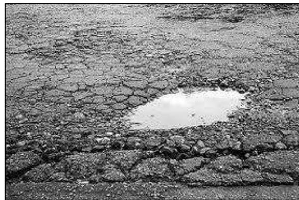
*Figura N°3. Drenaje en la carpeta asfáltica deficiente*
