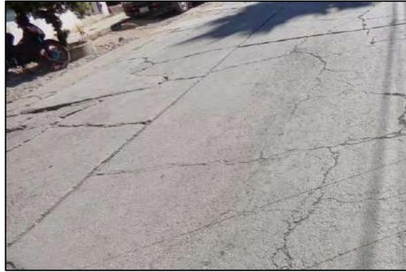
*Figura N°2. Agrietamiento en la carpeta asfáltica*
