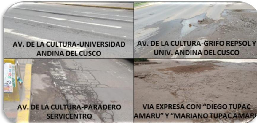
Figura 1: Fallas en los pavimentos.
