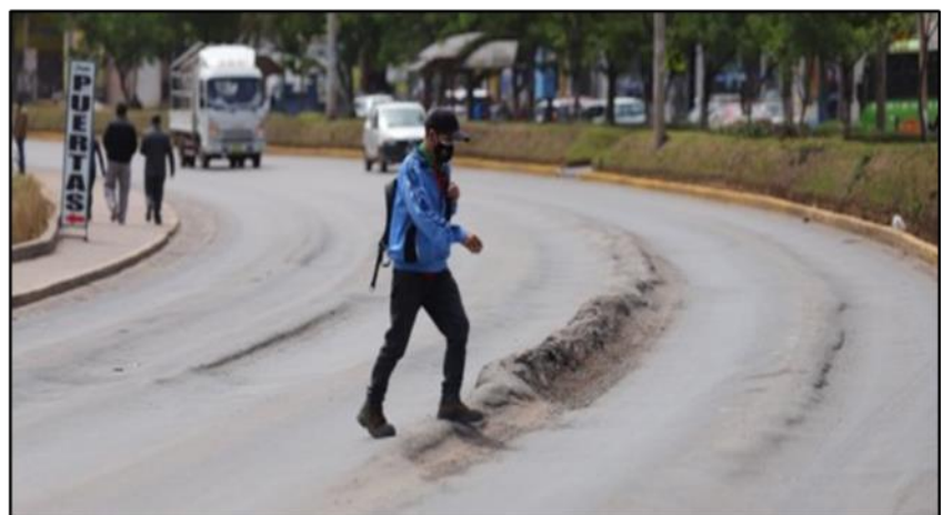
Figura 1 Problemas en la Infraestructura Vial Pavimentada, Av. de la Cultura: Baches y Deformaciones
