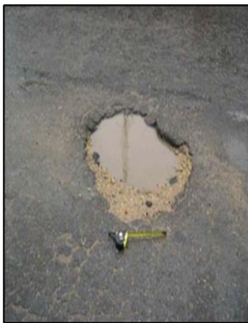
Figura 1 Problemas en la Infraestructura Vial Pavimentada, Av. de la Cultura: Baches y Deformaciones
