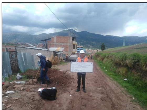
Figura 37 Excavación de Calicatas
