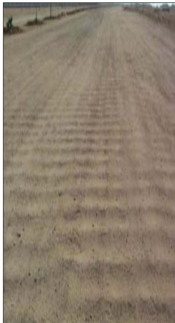
Figura 3 Problemas en la Infraestructura Vial No Pavimentada: Ondulaciones (Encalaminado) y Lodazales
