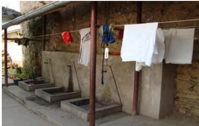
Muro de la epístola parte exterior.
