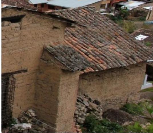
Figura 14 Vista exterior de la sacristía del templo San Cosme y San Damián de Lares
