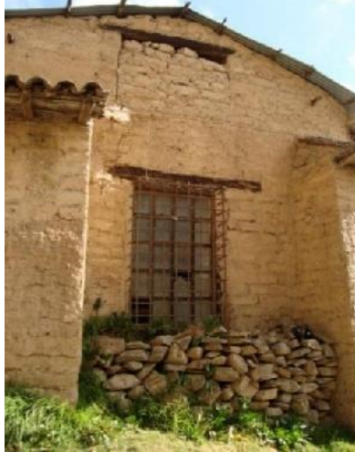
Figura 19 Vista exterior del muro testero.
