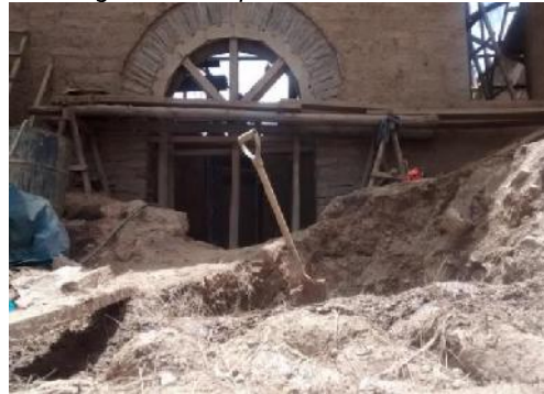
Figura 60 Preparación del mortero
