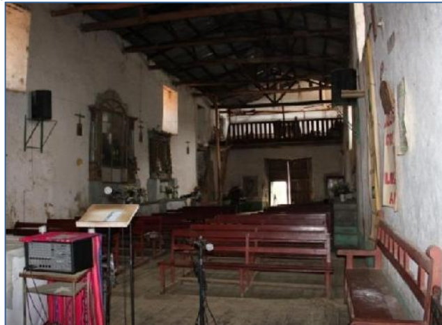
Figura 11 Nave del templo San Cosme y San Damián de Lares
