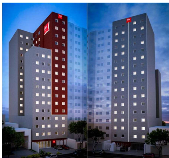
FIGURA 14: IBIS HOTEL Reducto - Fachadas
