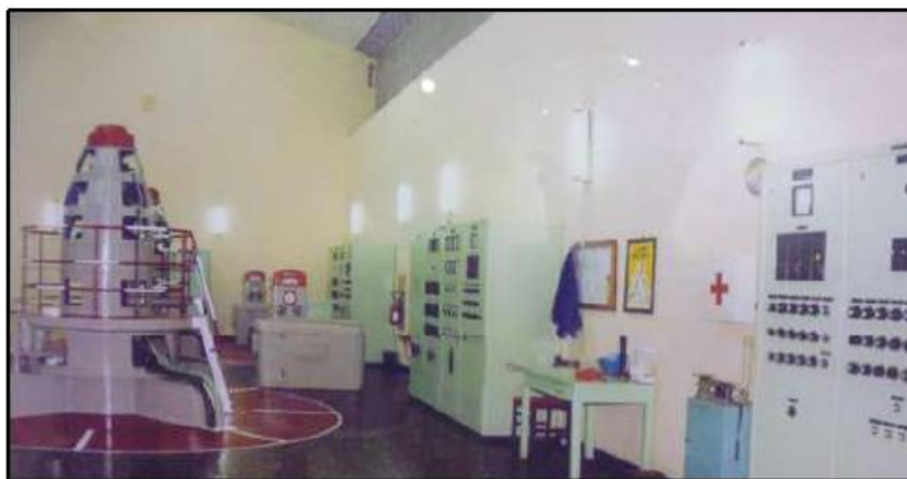
Ilustración 32: Sala de Máquinas II Fase. Grupo Francis - Antes del Incidente de 1998
