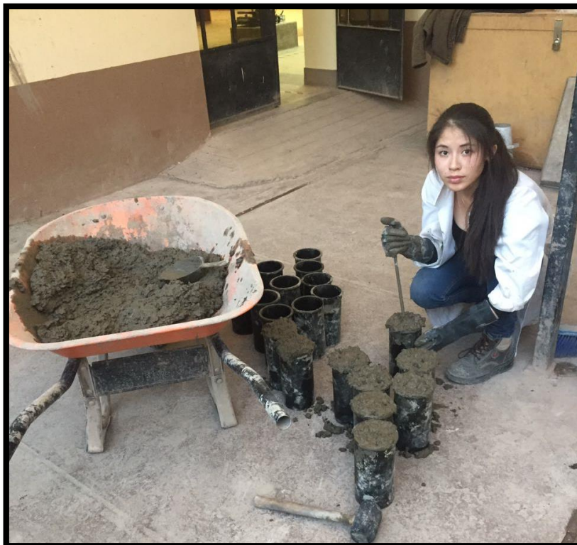
Figura 165: Compactación de la capa de concreto fresco sobre el concreto viejo
