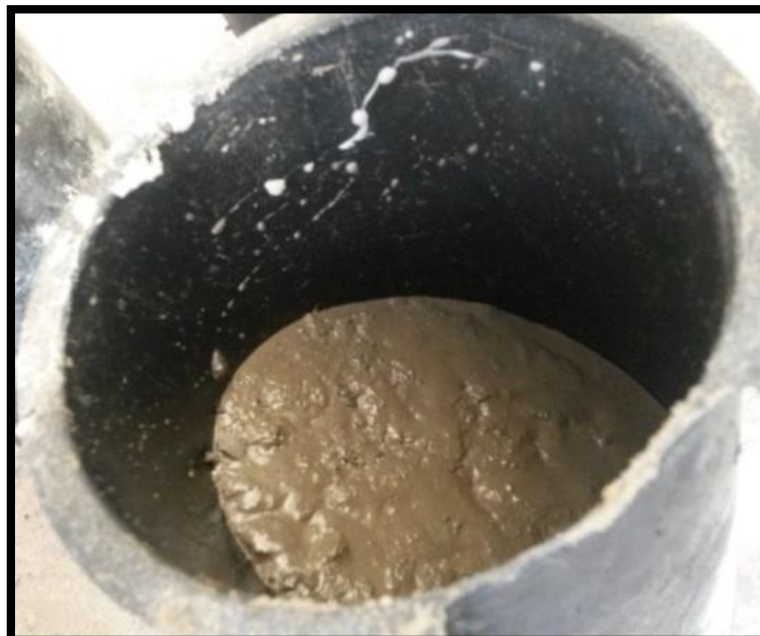
Figura 78: Junta fría diagonal en la primera capa de concreto
