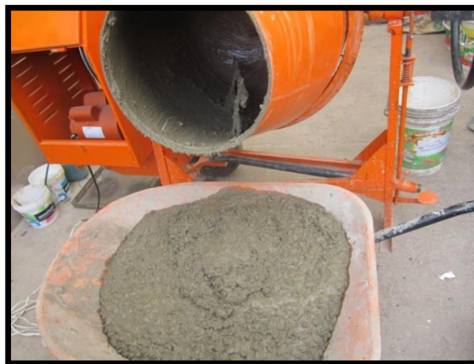
Figura 74: Colocación de concreto fresco en carretilla para facilitar su manejo
