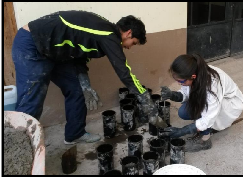
Figura 75: Compactación de primera capa de concreto fresco
