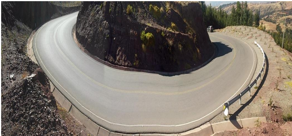
Figura: 1 Curvas con radios por debajo del mínimo establecido progresiva 6+320.
