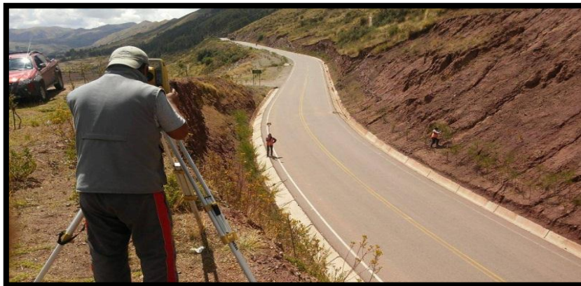
Figura: 23 Estacionamiento en el punto de cambio
