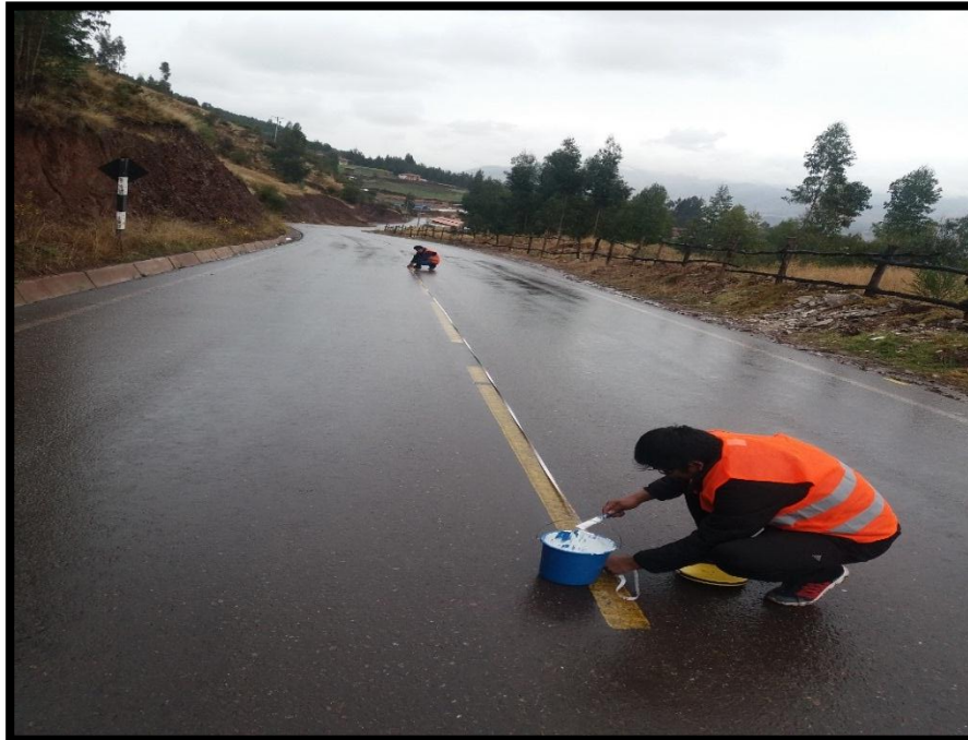
Figura: 39 Marcación de las progresivas en el eje de la vía
