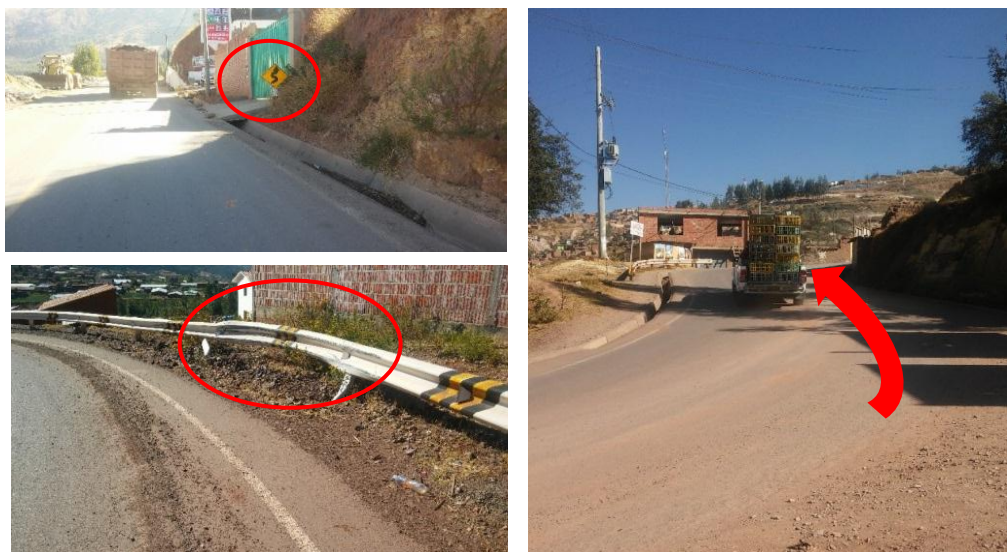
Figura: 2 Barandas de seguridad con presencia de abolladuras, señalizaciones inoperantes y pendientes muy pronunciadas
