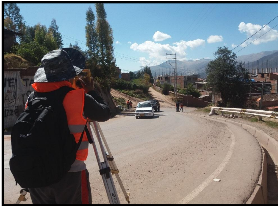
Figura: 38 Radiación de puntos
