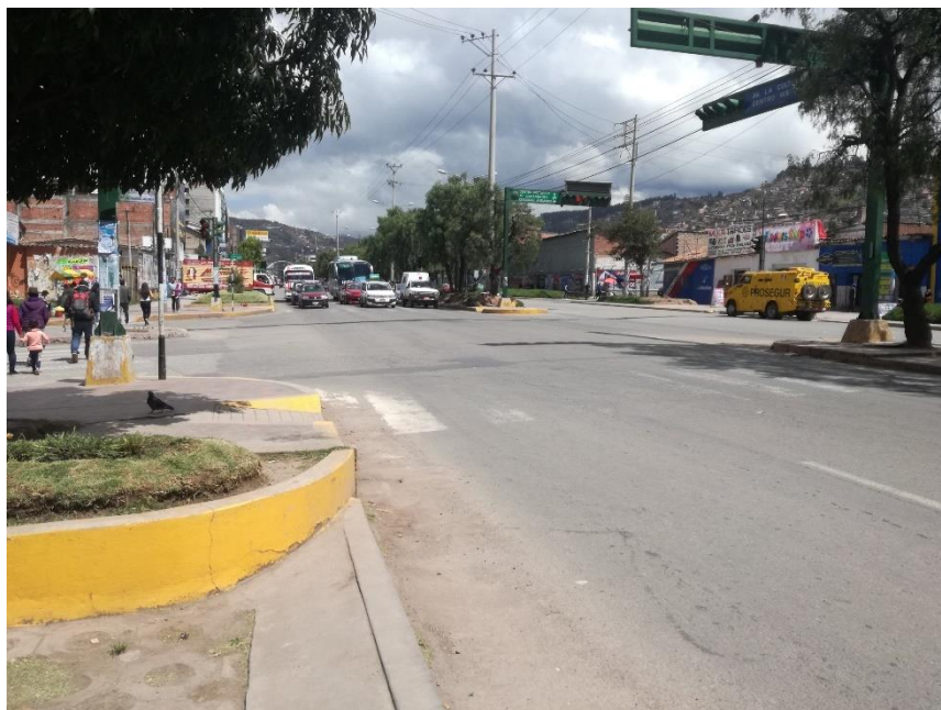
Fotografía 19: Intersección Semaforizada Av. La Cultura – Manuel Prado
