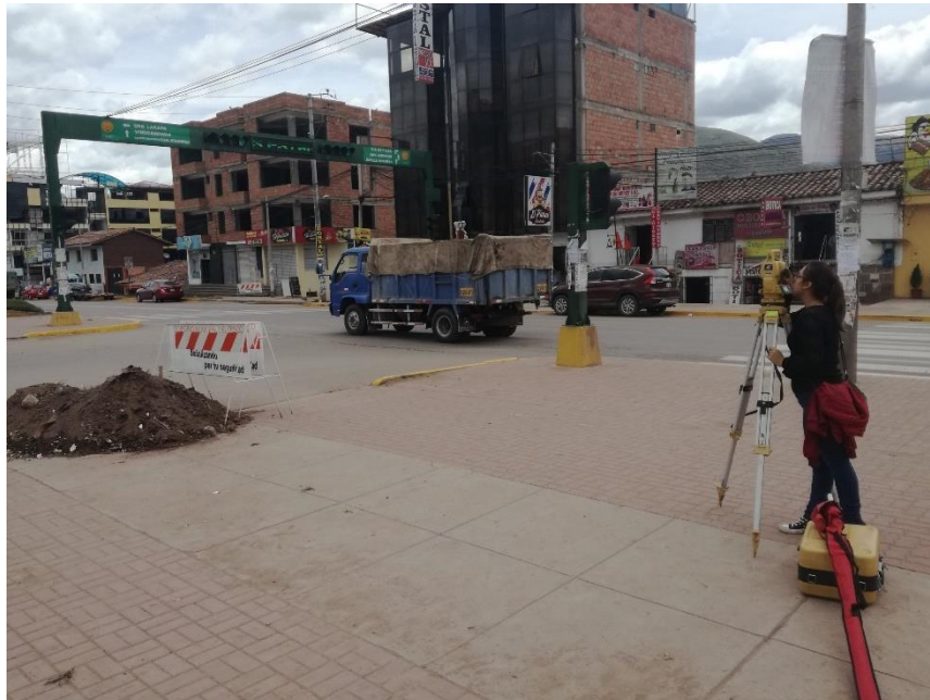
Fotografía 38: Levantamiento topográfico intersección Semaforizada Prolongación Av. La Cultura – Universidad Andina del Cusco
