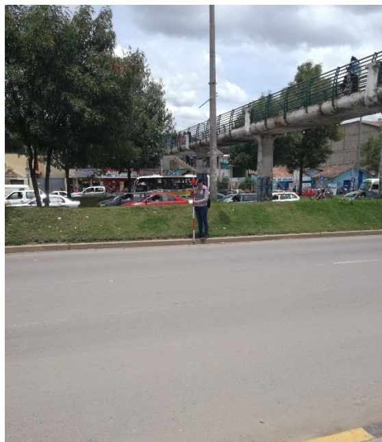
Fotografía 27: Levantamiento topográfico en la Intersección Semaforzada Av. 28 de Julio- 3er paradero de Ttio
