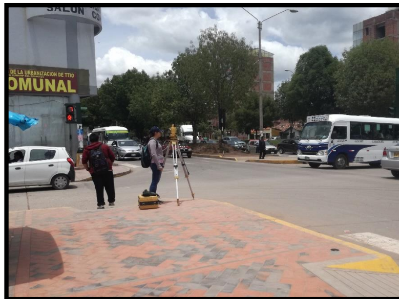
Fotografía 6: Levantamiento Topográfico intersección Av. 28 de Julio – 3er paradero de Ttio
