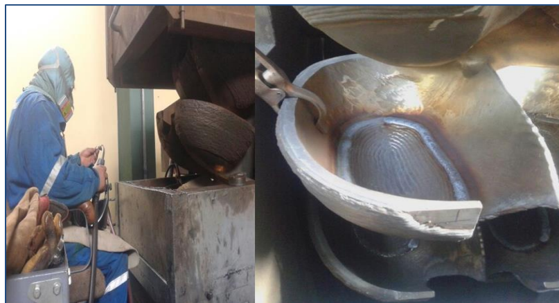
Figura N° 12: Soldadura de áreas delgadas.
