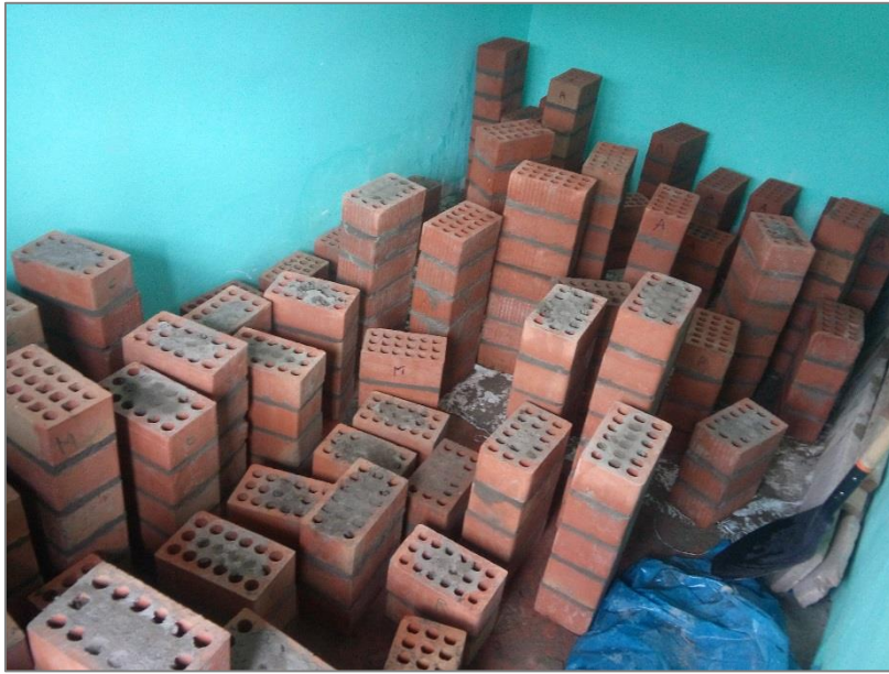
FIGURA N° 104: Almacenamiento de pilas de albañilería
