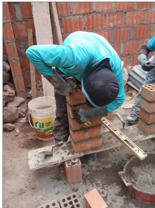
FIGURA N° 101: Control de espesor de junta de mortero para pilas de albañilería
