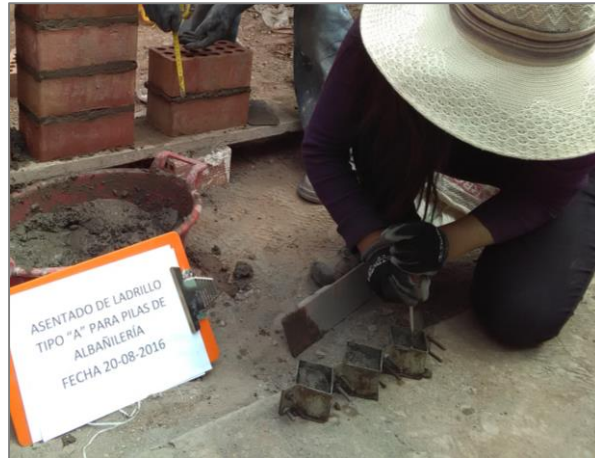
FIGURA N° 53: Apisonado de mezcla fresca para testigos de mortero
