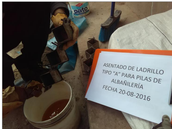
FIGURA N° 52: Impregnado de lubricante en pared de moldes metálicos
