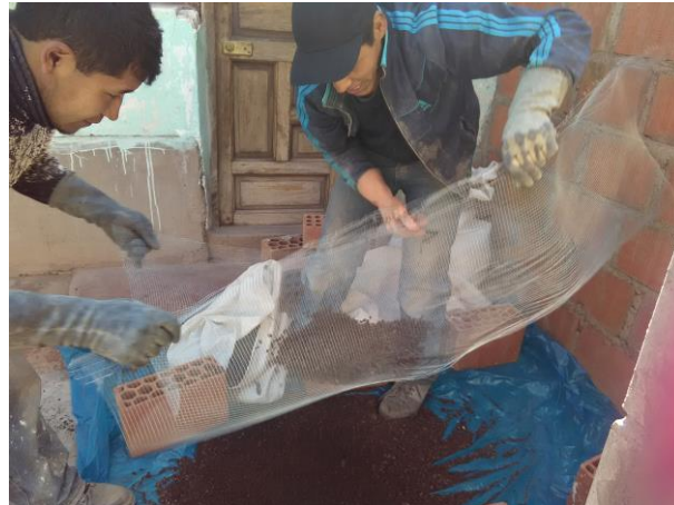
FIGURA N° 45: Tamizado de confitillo antes del asentado
