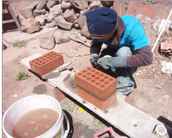
FIGURA Nº 46: Asentado de ladrillo King Kong 18 huecos en pilas de albañilería
