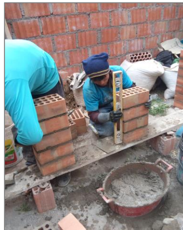
FIGURA Nº 47: Control de verticalidad de pila de albañilería
