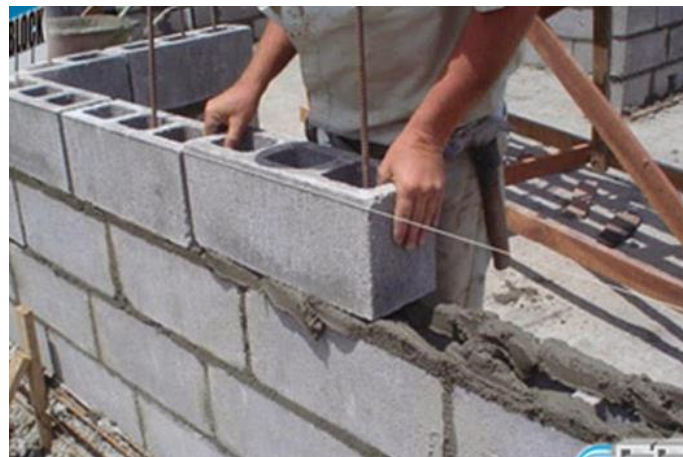
FIGURA N° 14: Asentado de bloque de concreto
