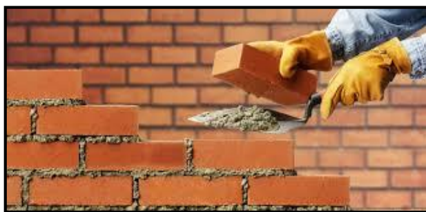
FIGURA N° 13: Manipuleo del ladrillo
