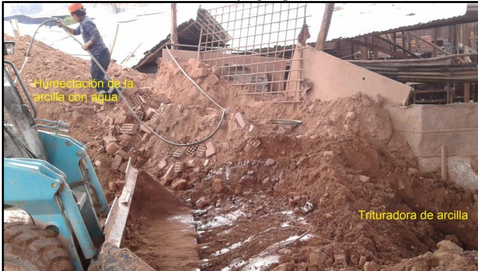
Foto N° 16: Dosificación de arcilla y agua para los ladrillos tradicionales
