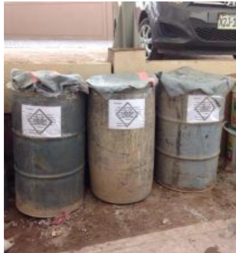
FIGURA N° 28: Cilindros para almacenar el agregado
