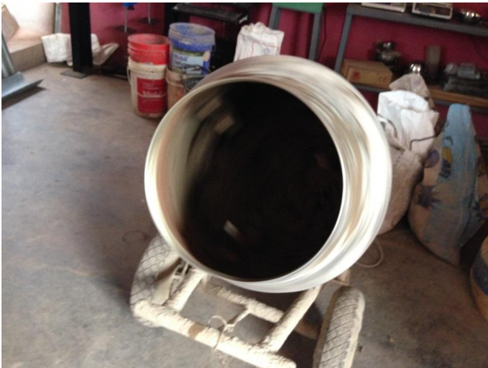
Batido del concreto con mezcladora
