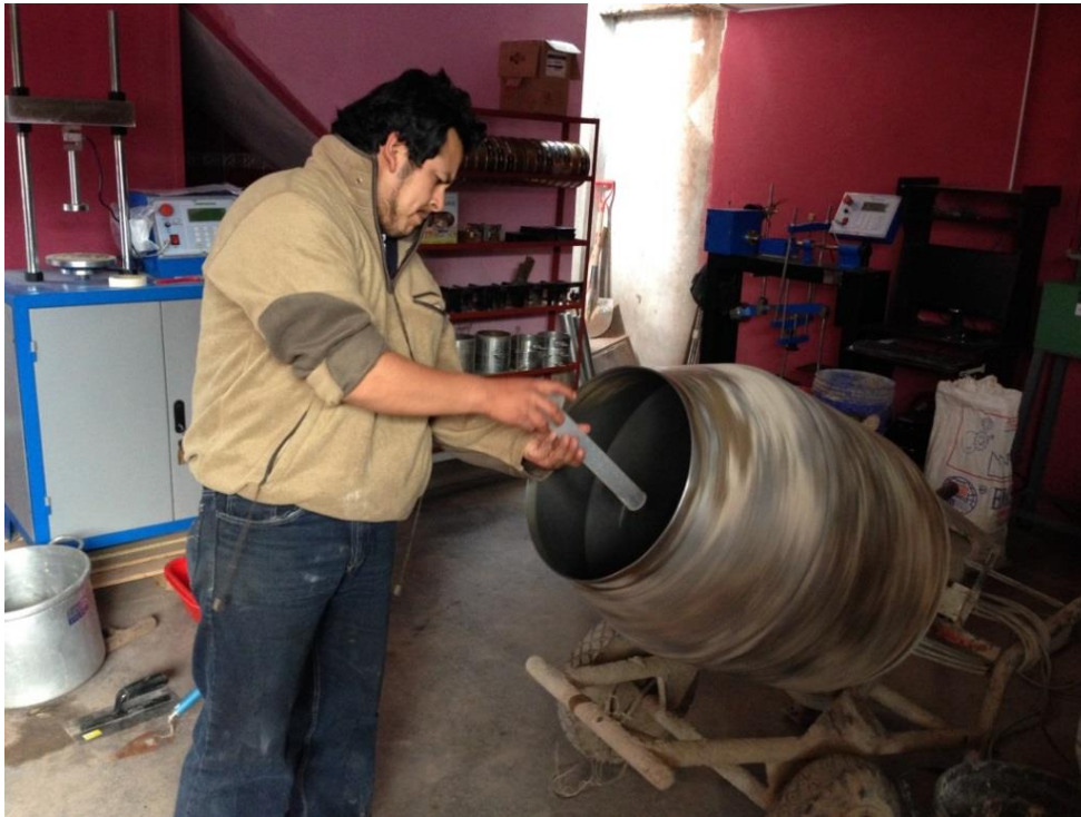
Adición de acelerante de concreto al agua de amasado
