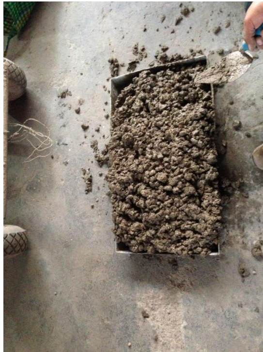
Se observa el concreto fresco
