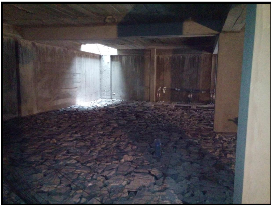
Vista del sótano de la edificación en el proceso de construcción
