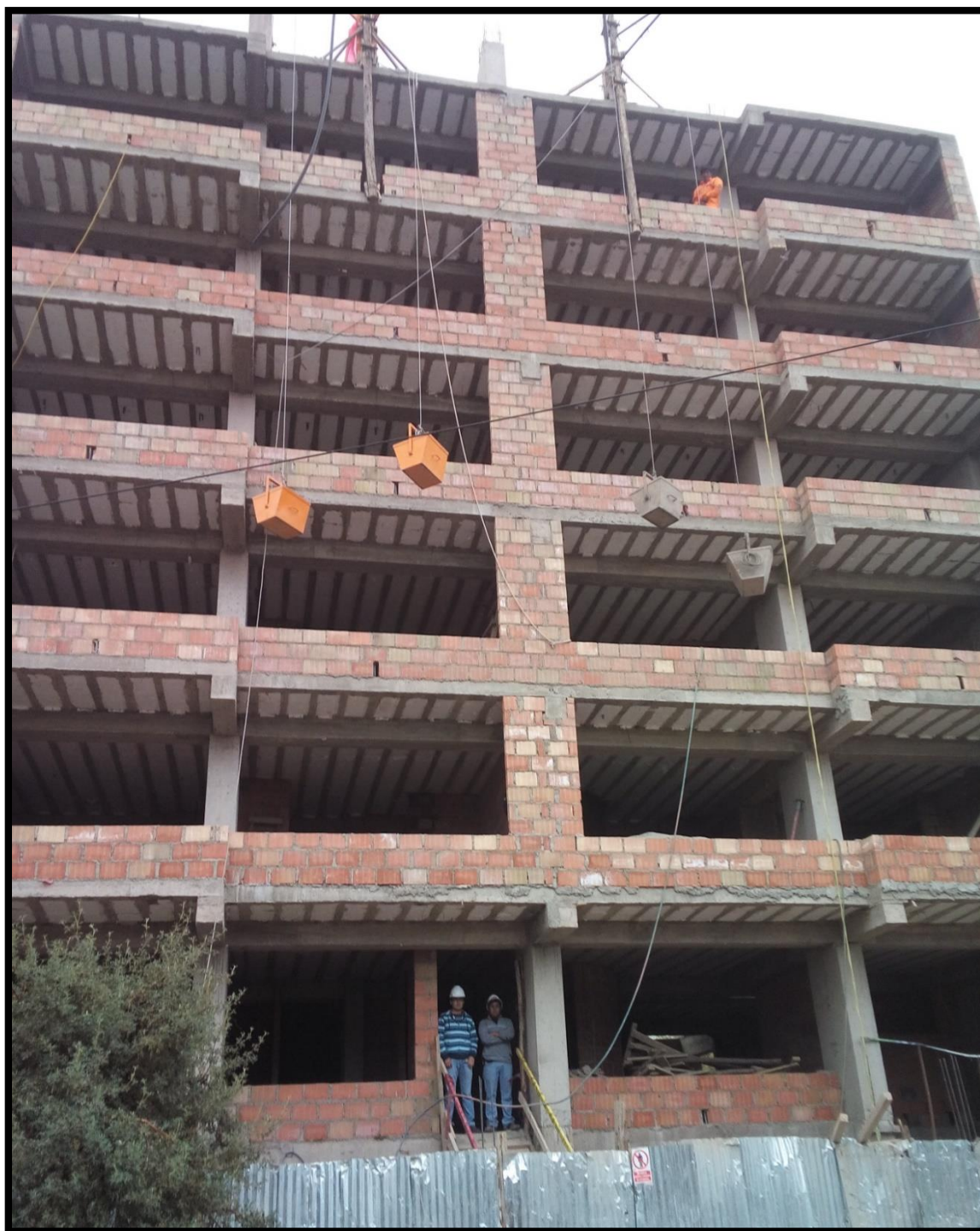
Vista de fachada de la edificación en el proceso de construcción
