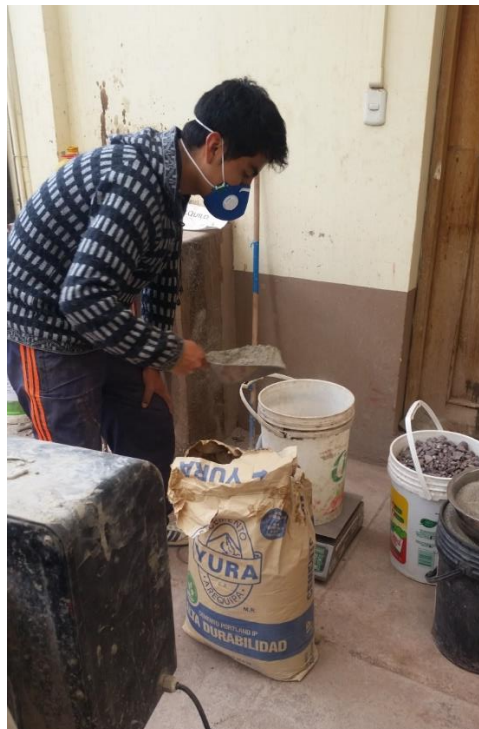
Fotografía 31: Preparado de materiales para vaciado - cemento
