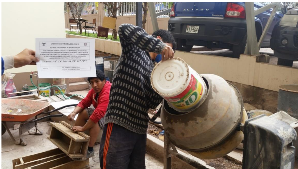
Fotografía 17: Elaboración concreto patrón
