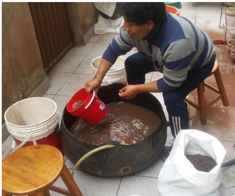
Fotografía 5: Lavado de agregado
