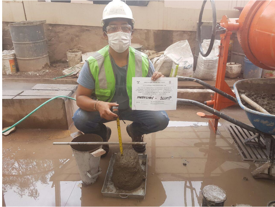
Fotografía 18: Toma de muestras de concreto
