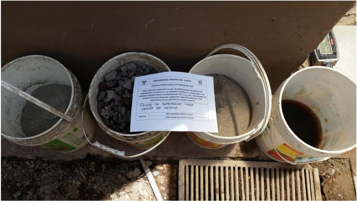
Fotografía 32: Preparado de materiales para vaciado - agregados
