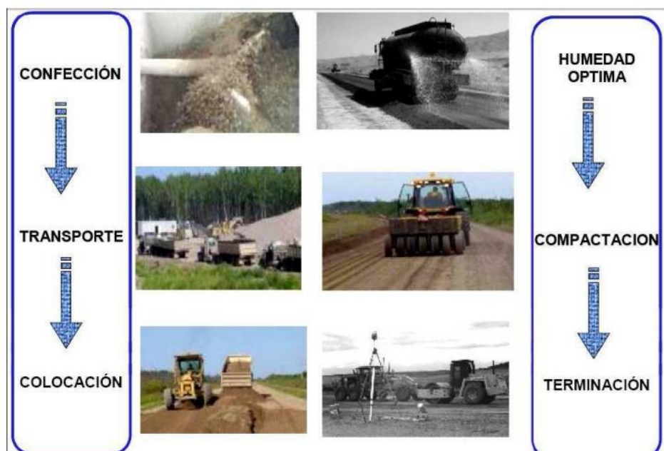
Figura 7: Etapas para la preparación de la base
